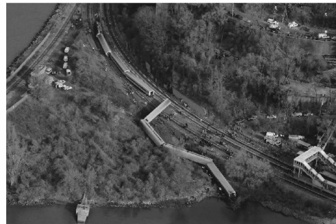
图 14 列车脱轨事故全景
