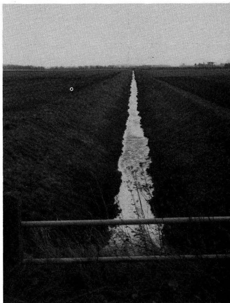
Abb. 3. Abflußgraben als Dränsammler im Trapezbett 1988.
