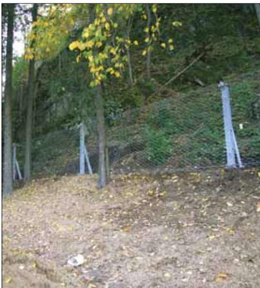
Abb. 6: Fangzaun unterhalb eines Felsens. Foto: J. Gross.
