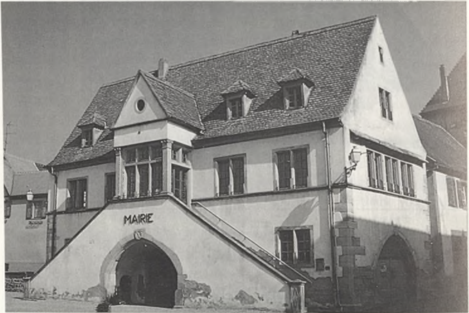
Abb. 18: Das Rathaus von Hattstatt, erbaut am Anfang des 16. Jahrhunderts, ist bei aller architektonischen Schlichtheit ein besonders typisches elsässisches Stubengebäude. Zwei Voll- und zwei Dachgeschosse, die doppelläufige Freitreppe zum Versammlungsraum im Obergeschoß und das einst offene Erdgeschoß, dessen Portale im Schlußstein das Gemeindegewappen tragen, sind die wichtigsten Erkennungsmerkmale.
