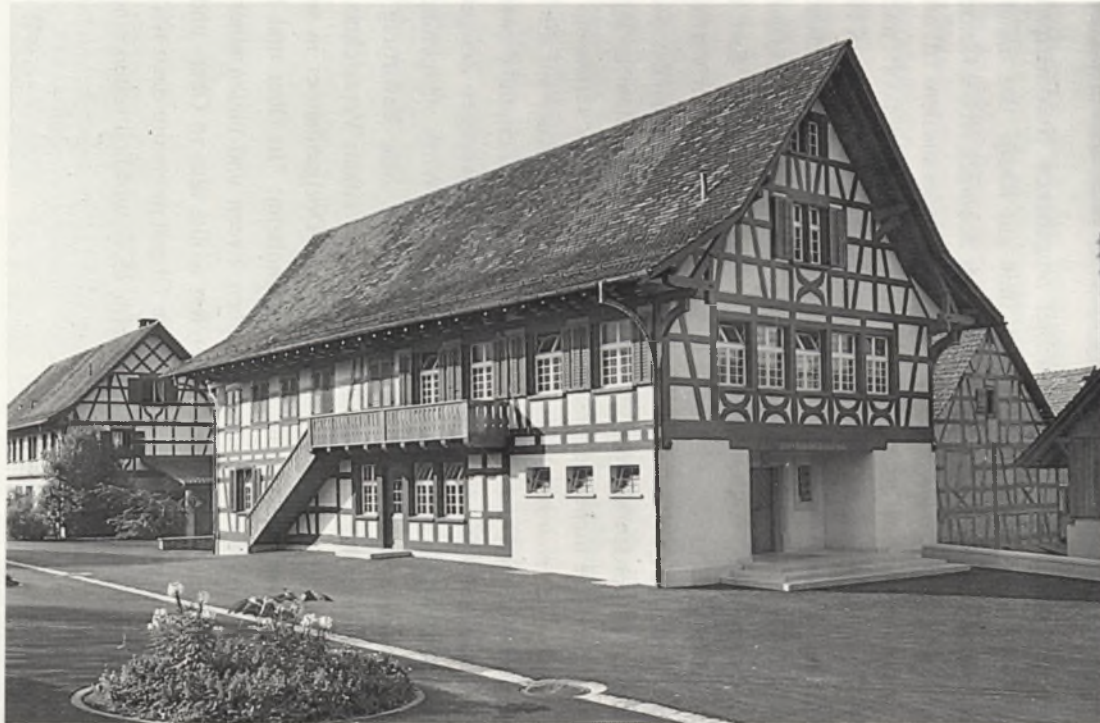
Abb. 2: Der vordere Teil des Gemeindehauses von Unterstammheim ist neueren Datums, doch ab der Höhe, an der das Fachwerk im Erdgeschoß einsetzt, haben wir noch das ursprüngliche Gebäude von ca. 1530 vor uns.
