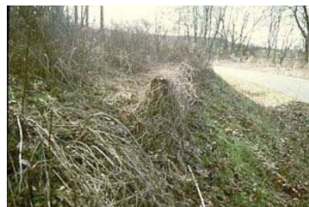
Abb. 1: Infolge mangelnder Pflege hängt die abgestorbene Vegetation über den Schutzzaun und ermöglicht so den Amphibien ein Überklettern (L 873 bei Ikenhausen)
