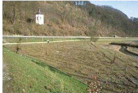
Abb. 4: Schutzanlage unterhalb des Rauschenberges an der B64/83 bei Höxter
