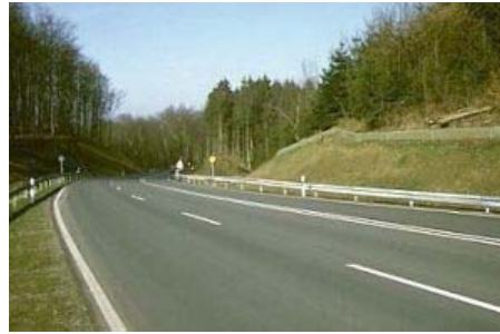
Abb. 3: Schutzanlage an der L 823 bei Marienmünster
