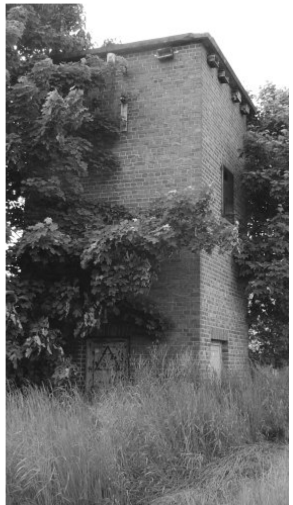
Abb. 4: Aufgelassener Trafoturm an der Alten Ziegelei
