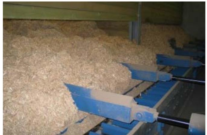
Abb. 2: Energetische Nutzung des Waldrand-Holzes: Hackschnitzel-Feeder eines größeren Holz hackschnitzel-Heizwerks in Brakel, Kreis Höxter (Foto: Walter KÖBLE).
