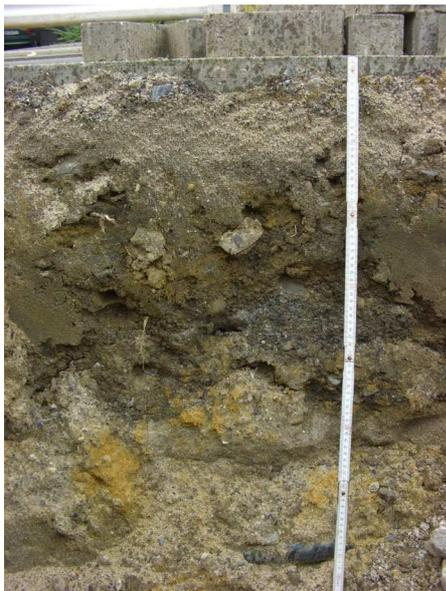
Abb. 1: Typischer Aufbau eines Stadtbodens unter einem Gehsteig. Mehrschichtige Abfolge von Bausand und umgelagertem anstehendem Boden (2010, T. KASIELKE).
