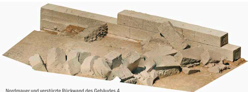
Nordmauer und verstürzte Rückwand des Gebäudes 4. Mur latéral et paroi arrière effondrée de l'édifice 4.
