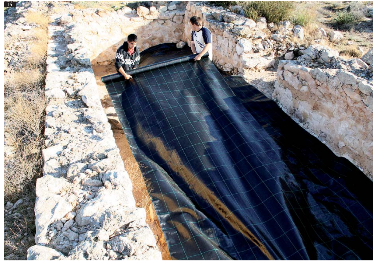
14. Treballs de conservació preventiva dels paviments de l'Edifici I. Any 2009. Arxiu Gràfic MARQ.
