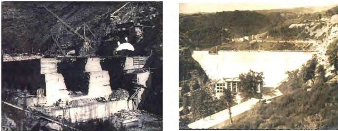
Figure 4-25 : Photographies du coulage des plots du barrage
