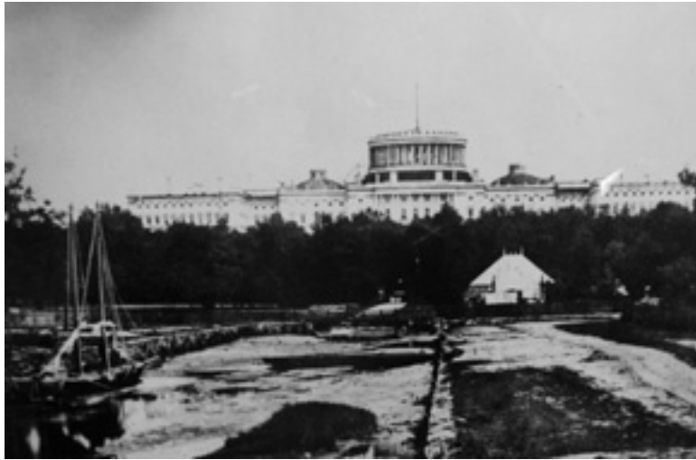
6 Bauarbeiten am Washington City Canal und an der Kuppel des US-Capitol zu Beginn des Amerikanischen Bürgerkrieges. Fotografie. Um 1861.
