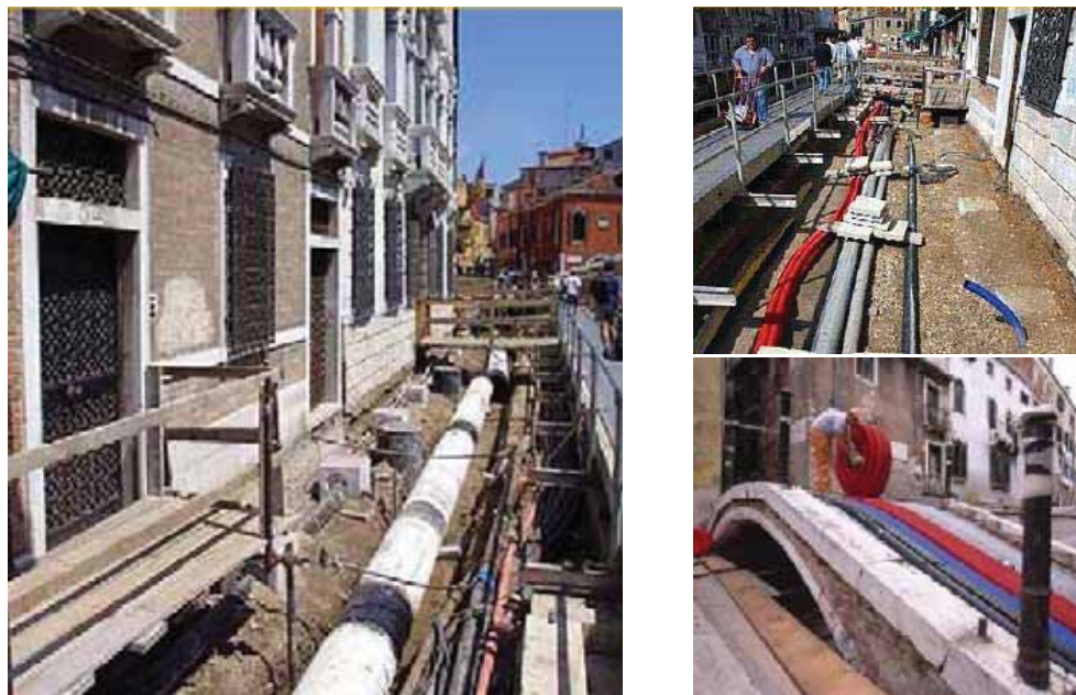
Fig. 1 Lavori di manutenzione e stesura della fibra
