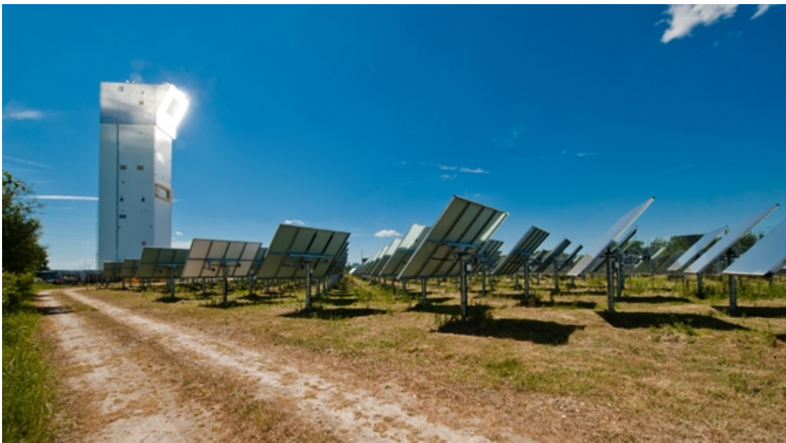
Abbildung 1.1: Solarturm Jülich (Quelle: DLR)
