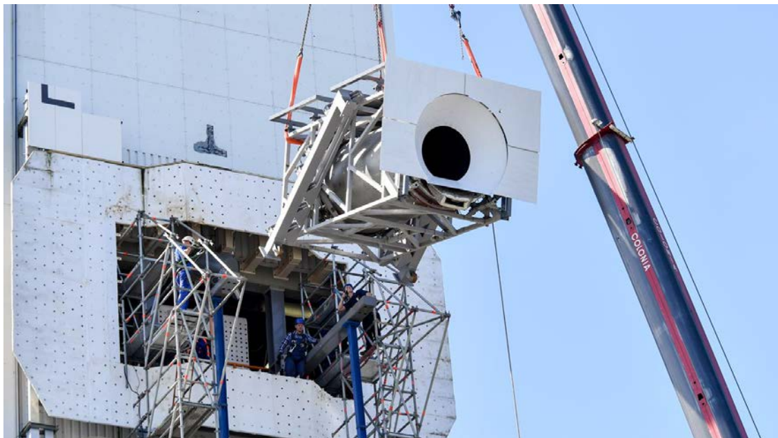
Abbildung 3.3: CentRec, Einbau auf der Forschungsebene [10]
