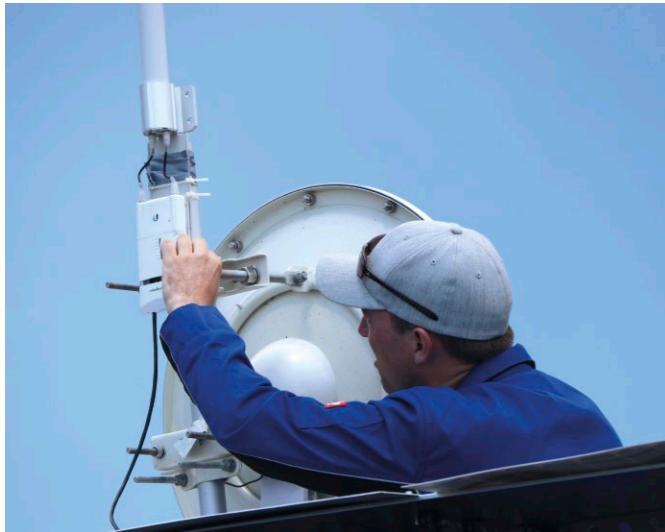
Nur wenn die Antennen exakt ausgerichtet sind, funktioniert die Kommunikation zwischen Lander, Rover, Sensorbox und Kontrollzentrum
