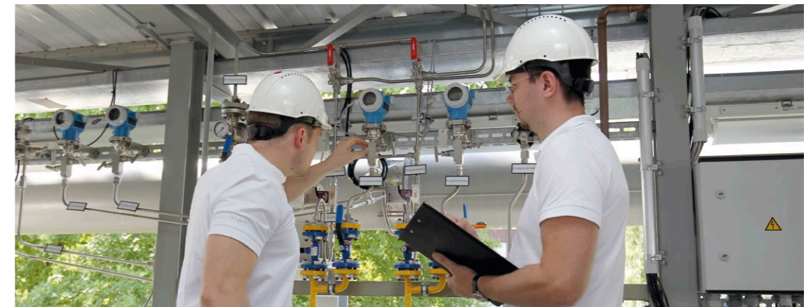
TESIS-Mitarbeiter stellen das Prozessgas-System ein
