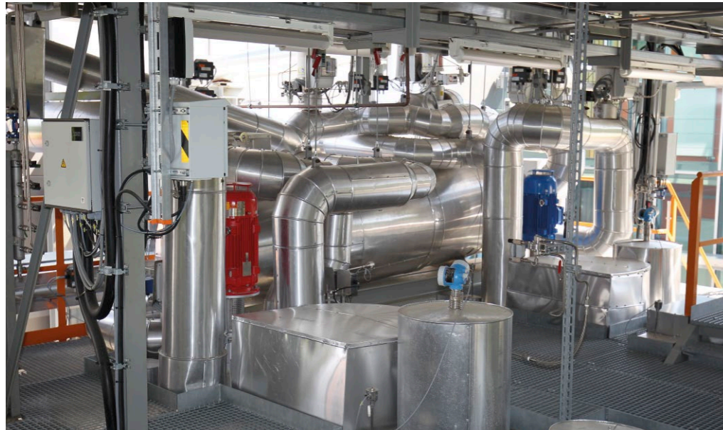
Die Anlage TESIS ist so konzipiert, dass sich die Salzmassenströme und ihre Temperaturen je nach Testanforderung differenziert regeln lassen
