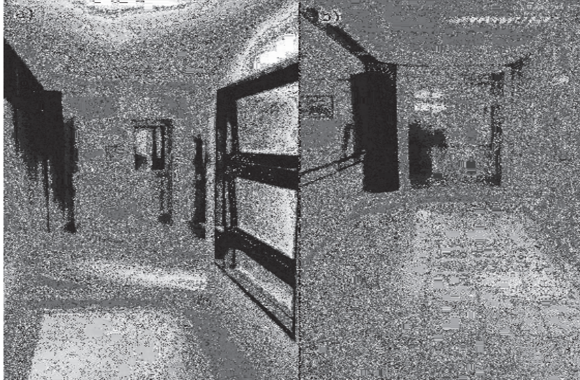
Gambar 5.5 Pintu yang Menghalangi Koridor
