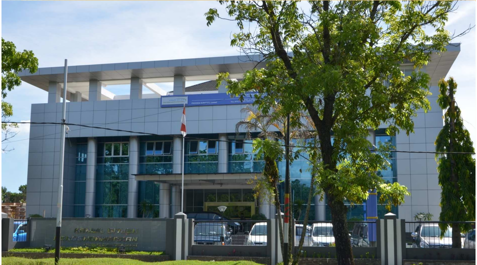
Kantor Wilayah Ditjen Perbendaharaan (Jalan Khatib Suleman, Padang)
