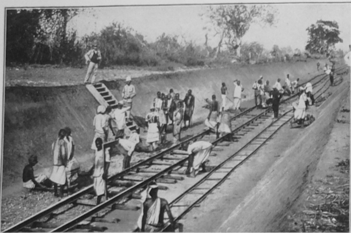
Erschließung des Verkehrs: Bau der Mittellandbahn
