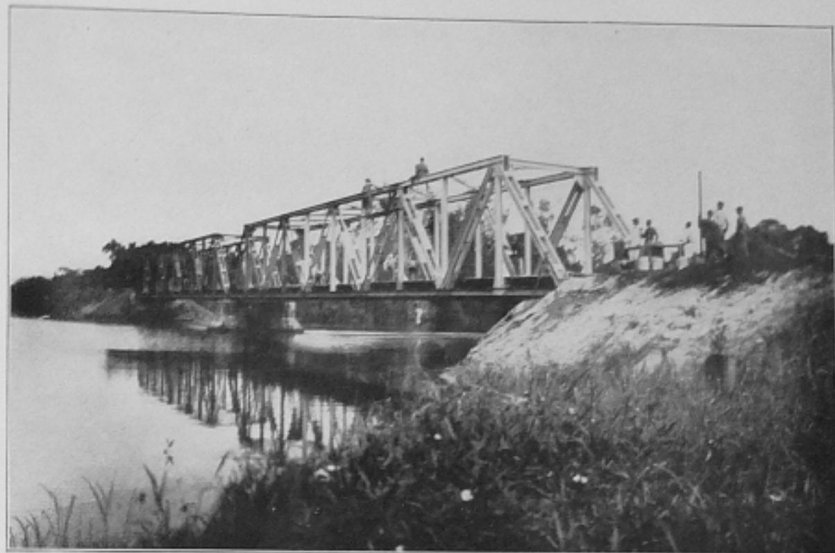
Brücke über den Bomono
