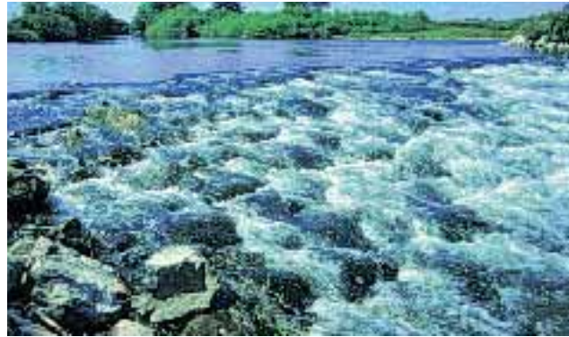
Abb. 2.8: Geschüttete Steinrampe bei Mittelwasserabfluss.
