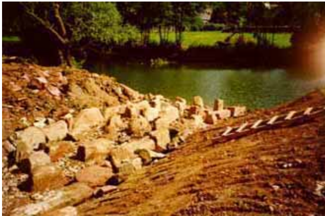
Abb. 3.112: Oberwasserseitiger Einlaufbereich im Bauzustand.
