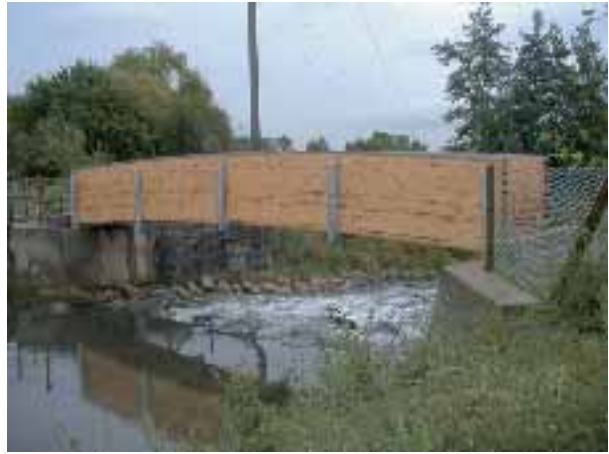
Abb. 2.98: Blick vom Oberwasser nach Fertigstellung.
