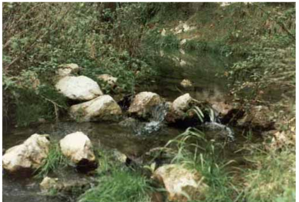
Abb. 4.55: Blick auf den oberwasserseitigen Einlaufbereich mit Wehranlage ca. 1 Jahr nach Fertigstellung. Eine Reihe Steinriegel kontrolliert den Abfluss.
