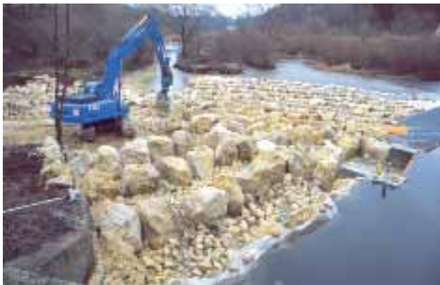
Abb. 2.206: Rampe von Oberwasser her in der Bauphase.
