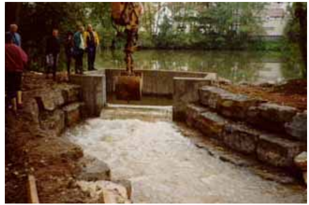
Abb. 3.62: Einlaufbauwerk im Bauzustand.
