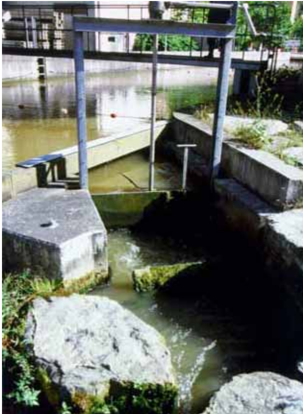
Abb. 4.33: Einlaufbereich im Oberwasser mit Regulierschütz.
