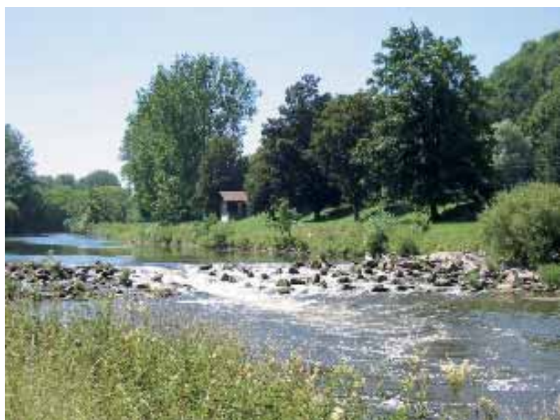
Abb. 2.138: Setzsteinrampe mit Bootsgasse.
