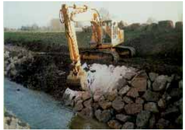
Abb. 2.123: Böschungssicherungsarbeiten.
