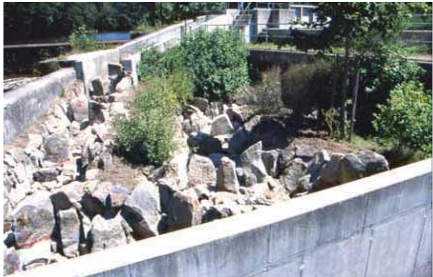
Abb. 4.44 und 4.45: Die Blocksteine sind in Wasserbausteinen und teilweise Beton eingebunden. Das Sohlenmaterial besteht aus Wasserbausteinen und Kies aus der Wiese.
