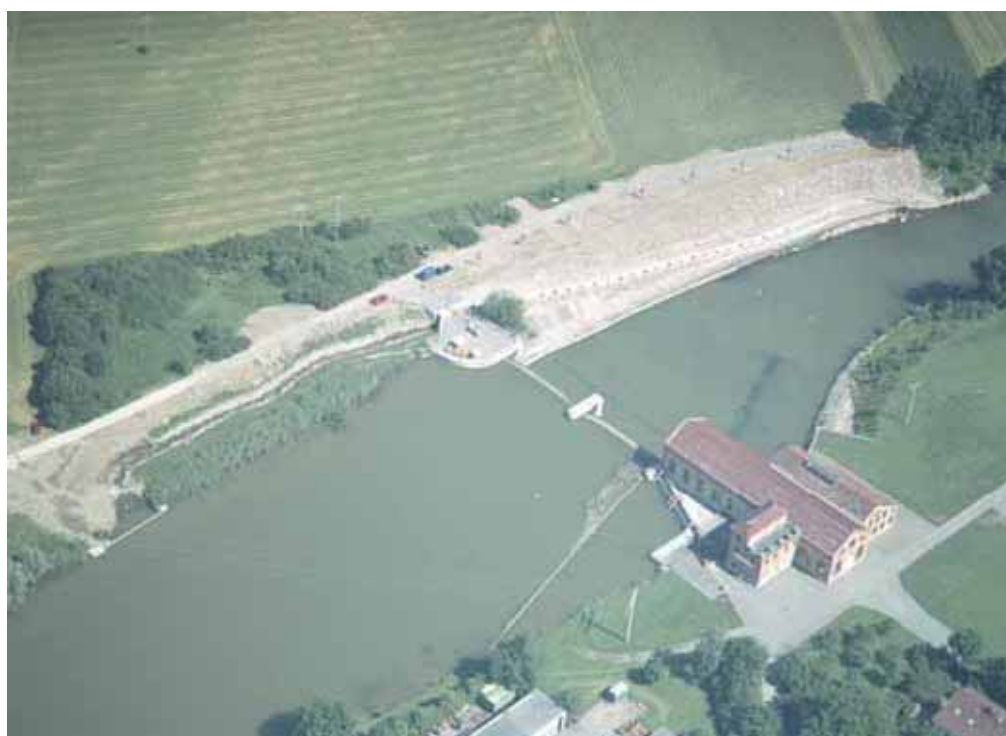
Abb. 4.78: Luftbild der Anlage, links Fischaufstiegsanlage, Mitte Schlauchwehr, rechts Wasserkraftanlage.
