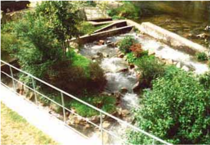
Abb. 4.47: Oberer/mittlerer Abschnitt des Umgehungsgewässers. Die Querriegel sind durch die Stauspiegelschwankungen im Oberwasser leicht überströmt.
