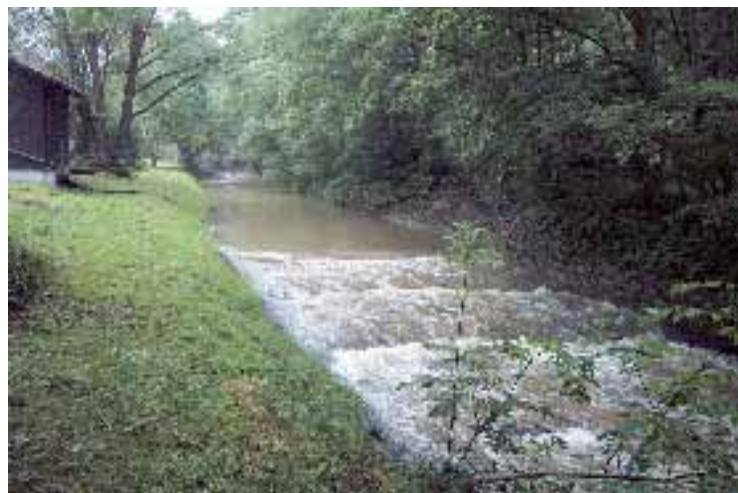
Abb. 2.142: Setzsteinrampe.
