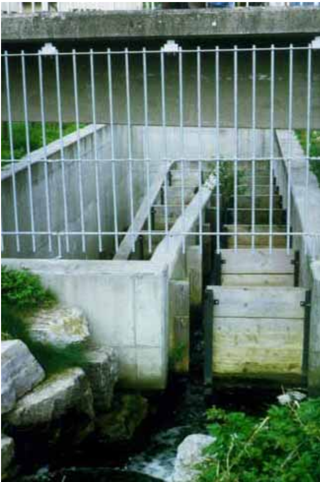
Abb. 4.28: Übergangsbereich naturnahes Gerinne/Vertical-Slot-Pass.
