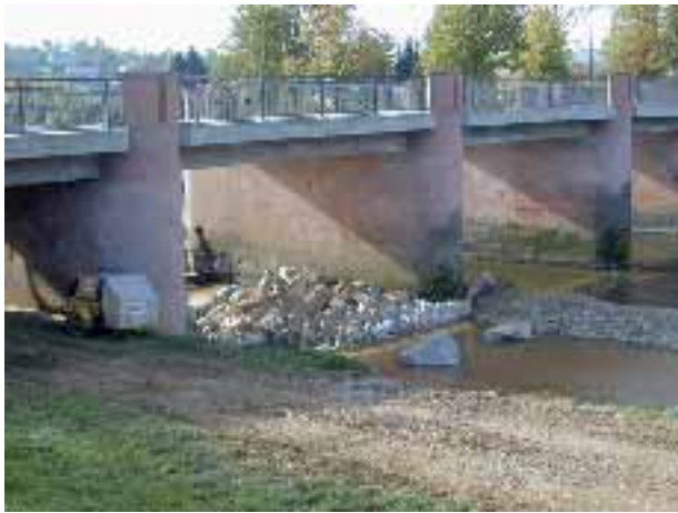
Abb. 2.119: Einbau Rampenkörper im rechten Wehrfeld.
