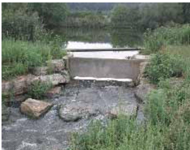
Abb. 3.15: Blick von unterstrom auf die Steinanordnung im Einlaufbereich. Schwimmbalken zur Abweisung von Treibgut und Betonwand zur Abflussbegrenzung im Hochwasserfall sind gut zu erkennen (WKA Kiebingen, Neckar).
