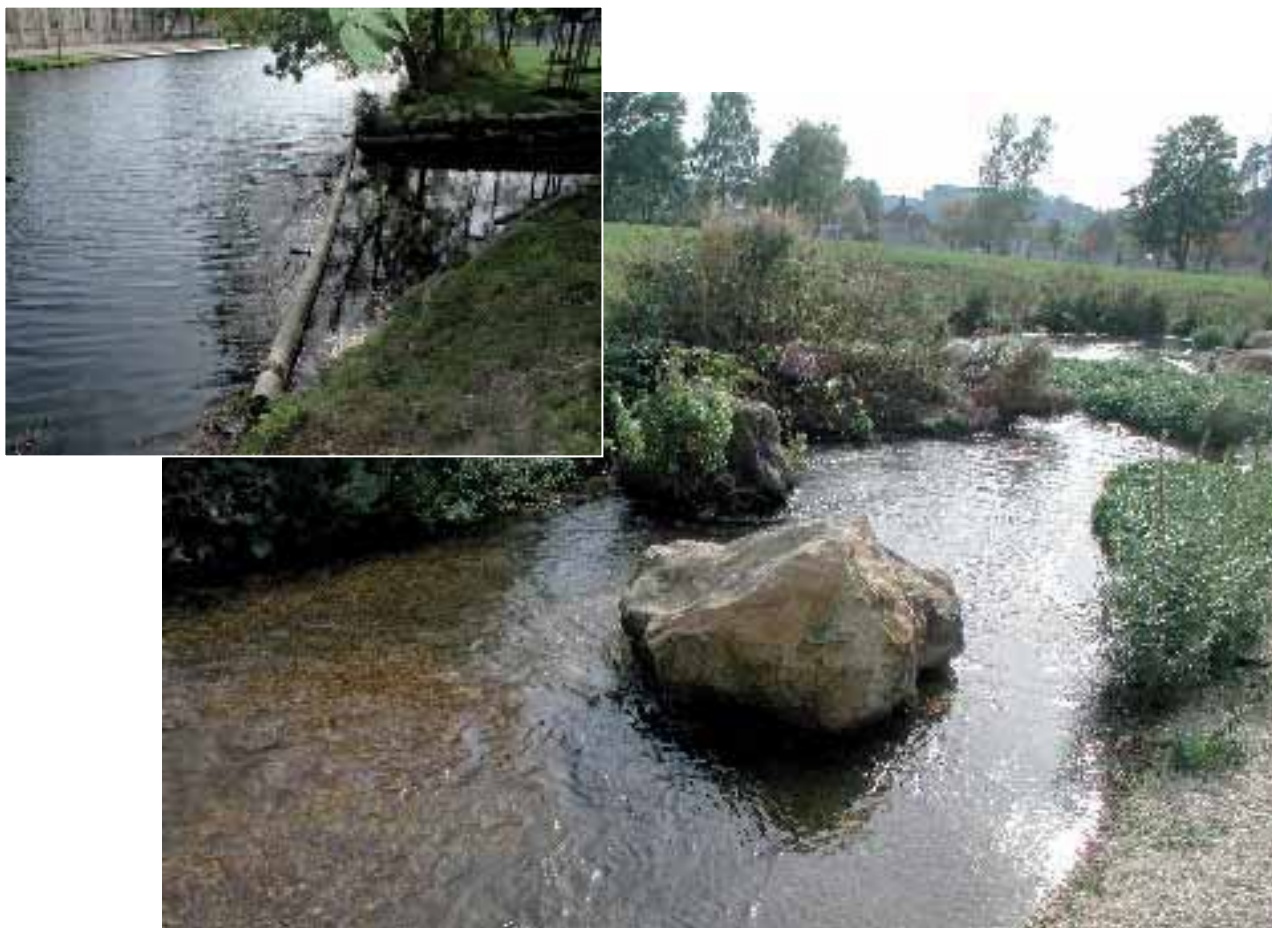
Abb. 1.2: Umgehungsgewässer in Heidenheim an der Brenz mit Einlaufbereich.
