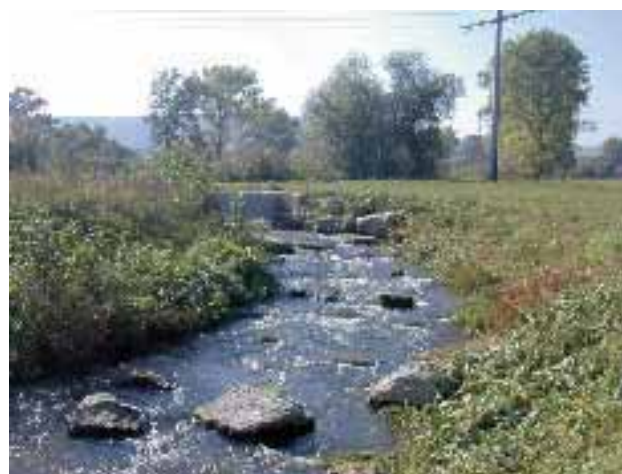
Abb. 3.7: Strömungsvielfalt durch Störsteine.
