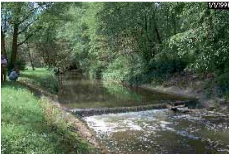
Abb. 2.141: Absturz (vor dem Umbau).
