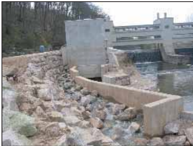
Abb. 3.125: Blick nach Oberwasser.
