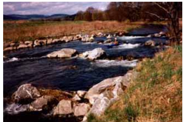
Abb. 4.11: Aufgelöste Wehrschwelle in der Haßlach.
