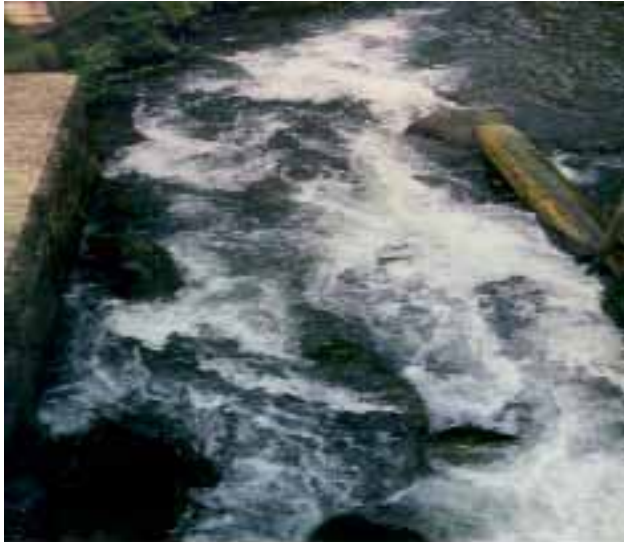
Abb. 3.34: Auslaufbereich eines Umgehungsgewässers mit gut ausgeprägter Leitströmung im Unterwasser.
