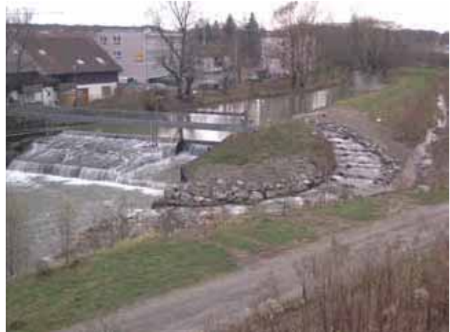
Abb. 4.84: Ansicht des Wehres und des Raugerinnes unmittelbar nach Fertigstellung. Deutlich sind die bogenförmige Linienführung des Raugerinnes und die massive Sicherung der Ufer zu erkennen.
