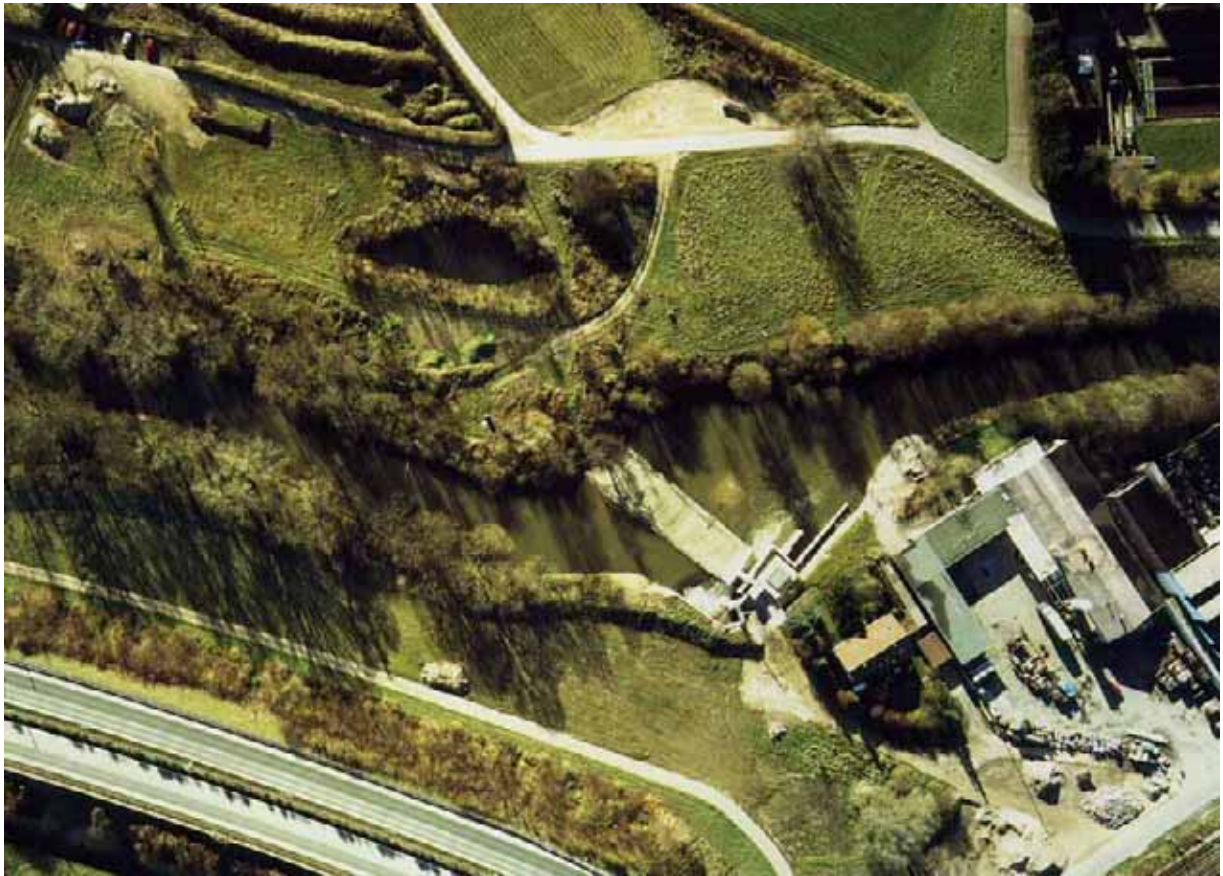
Abb. 3.88: Luftbildaufnahme der Anlage. Am rechten Ufer ist das Umgehungsgewässer zu erkennen.
