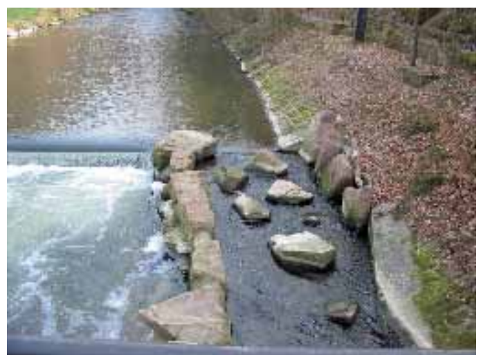
Abb. 2.213: Absturz vor dem Umbau.
