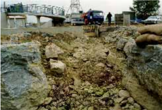
Abb. 3.117: Einlaufbereich vom OW aus gesehen im Bauzustand.
