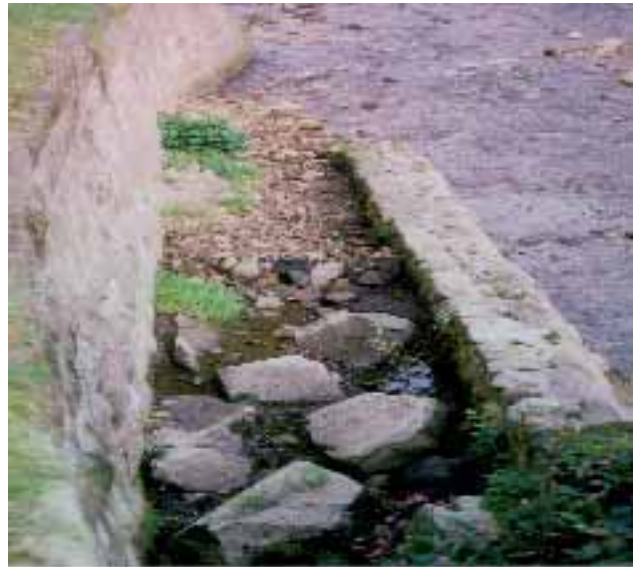
Abb. 3.35: Verlandeter Auslaufbereich.
