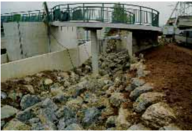
Abb. 3.119: Umgehungsgewässer im Bauzustand.
