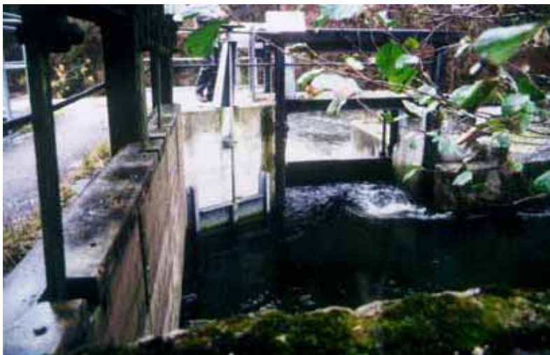
Abb. 4.46: Abzweig des Kombinationsgewässers vom Mühlkanal. Das regelbare Schütz dient als Tauchwand.
