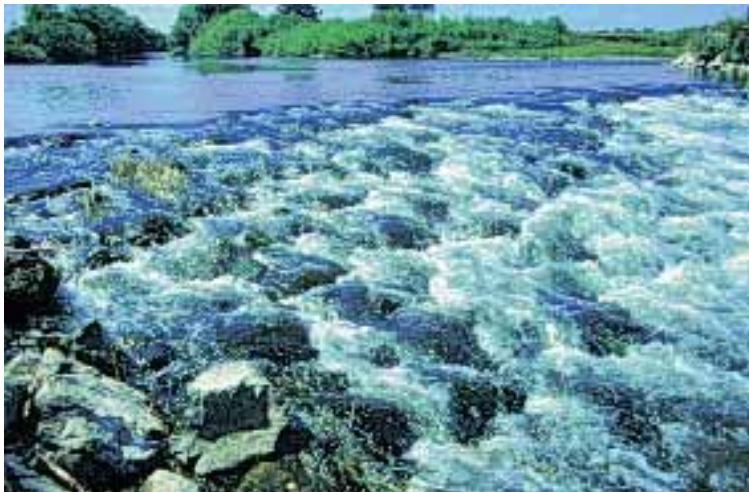
Abb. 2.152: Ansicht der Rampenkronen.
