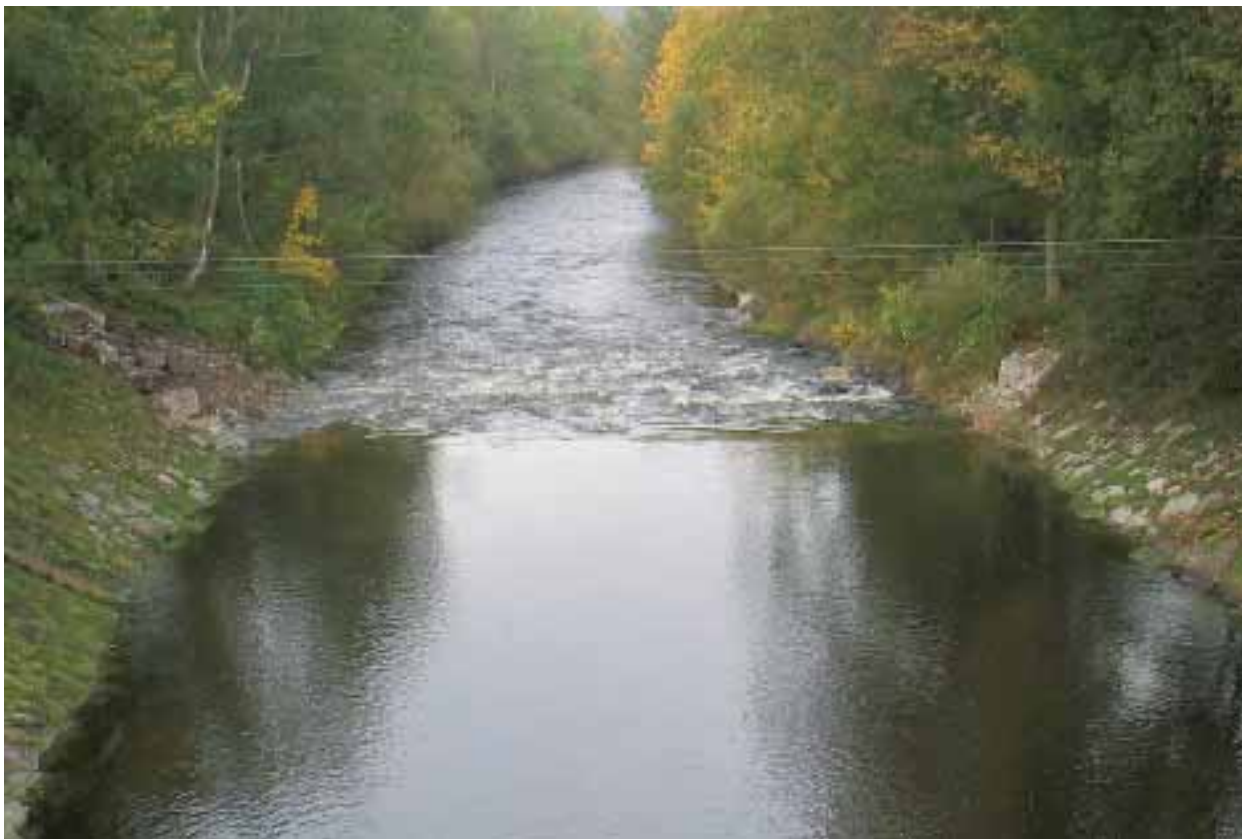
Abb. 2.175: Mit Spundwand gesicherte Schüttsteinrampe.
