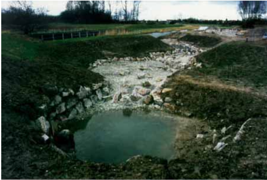
Abb. 3.43: Blick vom Durchlass des Umgehungsgewässers im HW-Damm in Richtung Unterwasser. Im Bauzustand sind der Kolksee, wechselnde Gewässerbreiten und die aufgelöste Riegelbauweise gut zu erkennen.
