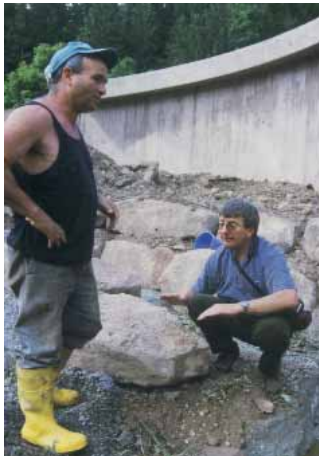
Abb. 3.9: Beim Setzen der Störsteine ist neben dem fachpraktischen Wissen der Bauaufsicht die Geschicklichkeit der Arbeiter von großer Bedeutung.
