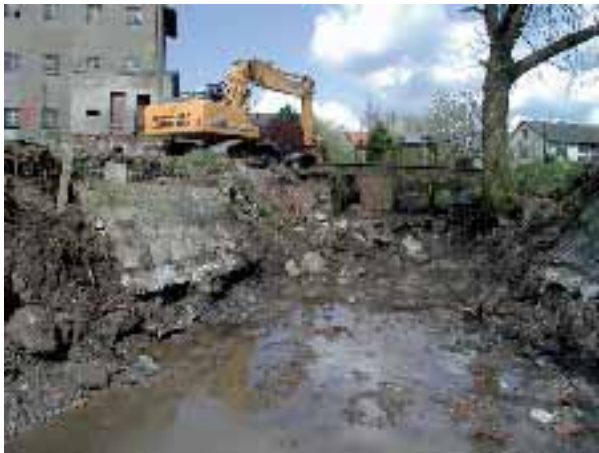
Abb. 2.128: Absturz nach Abbrucharbeiten.
