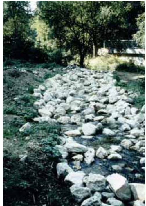
Abb. 4.53: Rampenbauwerk unmittelbar nach Fertigstellung.
