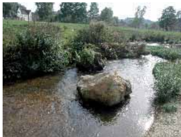
Abb. 3.6: Umgebungsgewässer mit lokaler Querschnittsaufwei- tung und eingebauten Störsteinen kurz nach der Fertigstellung. Die Böschungen sind flach geneigt und bepflanzt.
