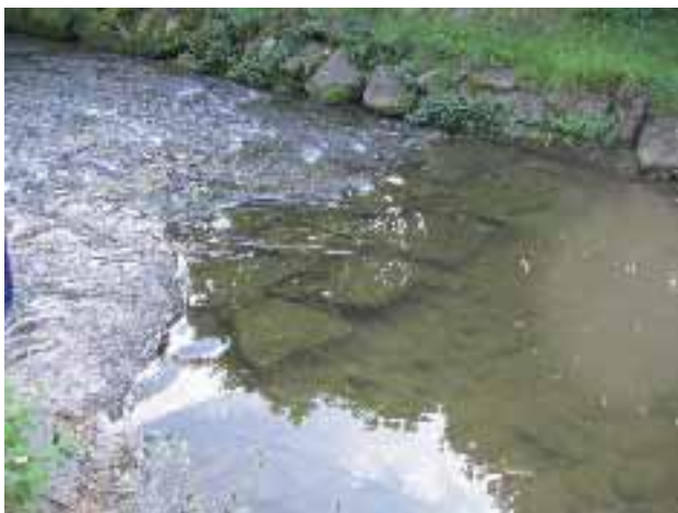
Abb. 2.71: Rampenkopf Pegel Rotach bei Friedrichshafen.
