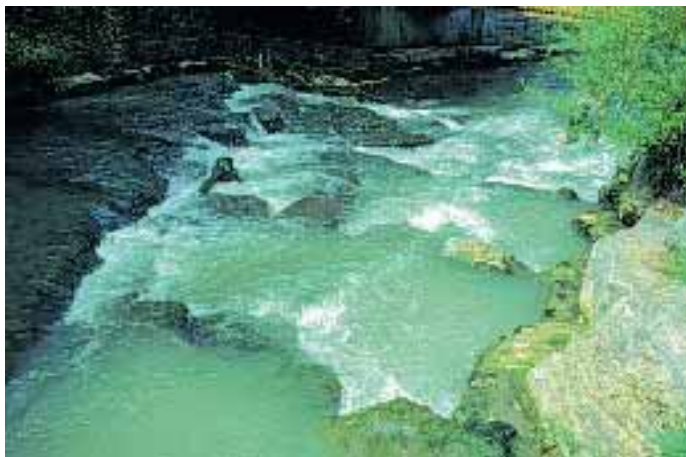
Abb. 2.106: Ansicht vom Oberwasser.
