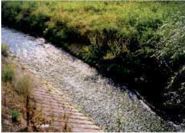
Abb. 2.122: Ursprüngliche steile, glatte Sohlengleite.
