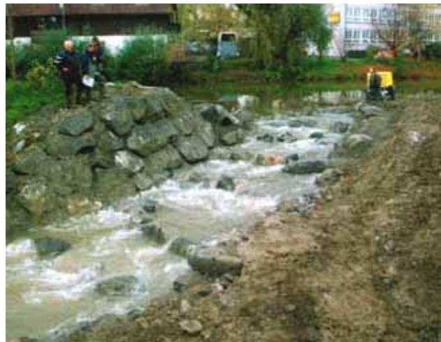
Abb. 4.86: Einlaufbereich des fertig gestellten Gerinnes. Erkennbar ist der schräge Einbau der Riegel zur Verlängerung der Fließstrecke.
