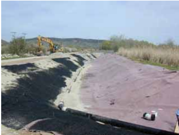
Abb. 4.72: Vlies über der PE-HD-Folie, Lockwasserstromleitung, Erosionsschutzmatte.
