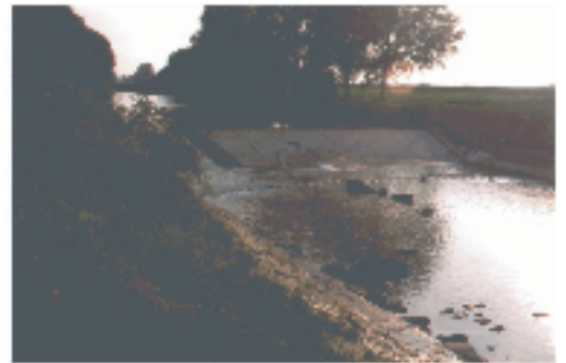
Stützschwelle nach dem Abstauen
