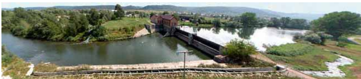
Abb. 4.1: Kombinierte Anlage, bestehend aus Umgehungsgewässer und Becken-Schlitz-Pass.
