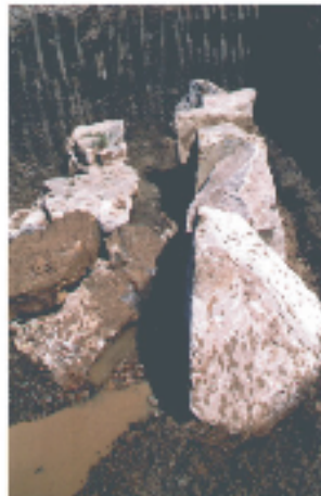
Querriegel im Bau, Einbindung in die Uferböschung
