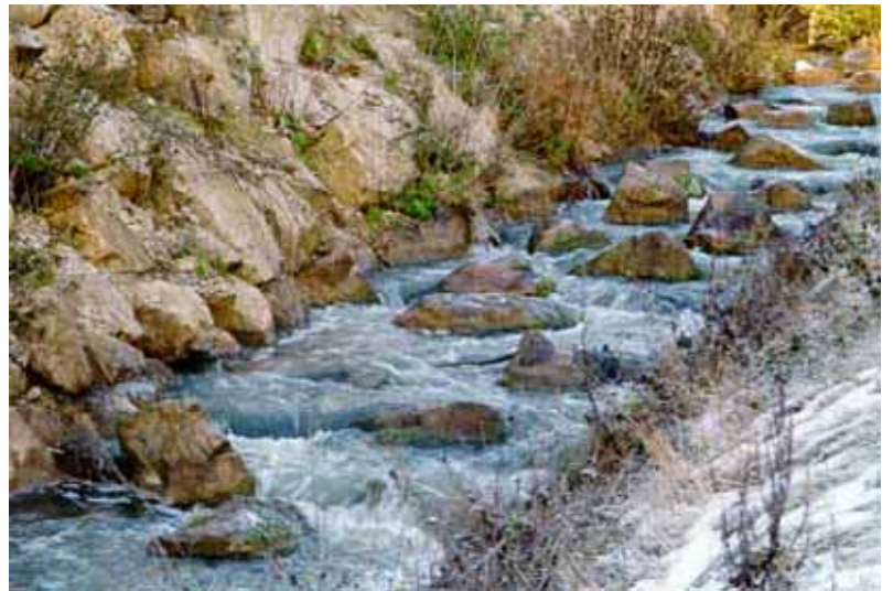
Abb. 3.72: Blick in das Umgehungsgewässer.
