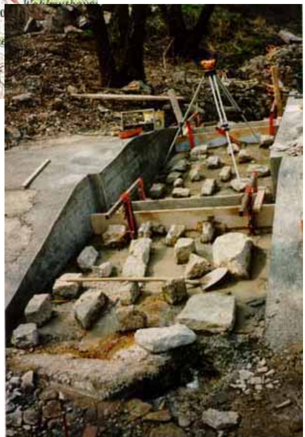
Abb. 3.48: Bauzustand des Einlaufbereiches.
