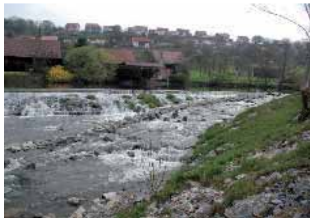
Abb. 2.67: Anschluss der Teilrampe an das Unterwasser.
