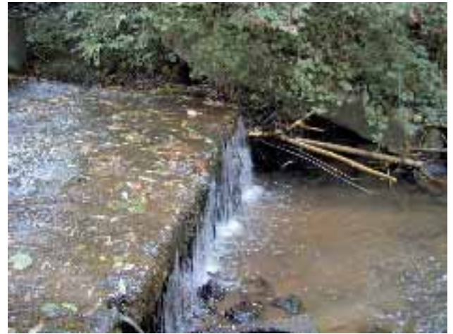
Abb. 2.191: Absturz am Ende des Wehres.
