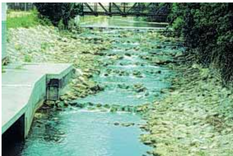
Abb. 2.176: Ansicht vom Unterwasser.
