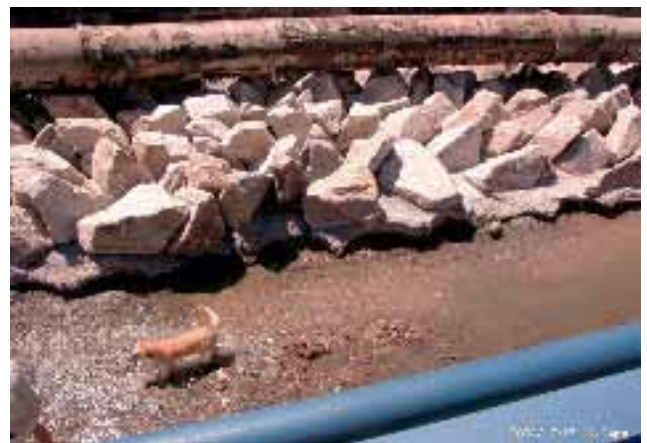
Abb. 2.4 a+b: Bau eines Rampendeckwerks in Setzsteinbauweise an der Alb bei Ettlingen. Als Unterbau wurde Einkornbeton verwendet.
