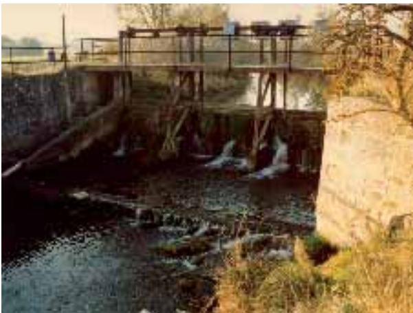
Abb. 2.99: Blick vom Unterwasser mit alter Schützenanlage.
