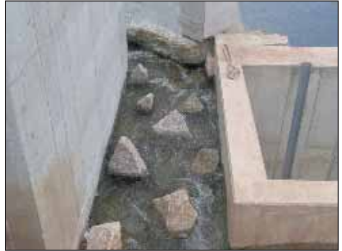
Abb. 3.124: Ruhezone im Bereich minimalen Gefälles.
