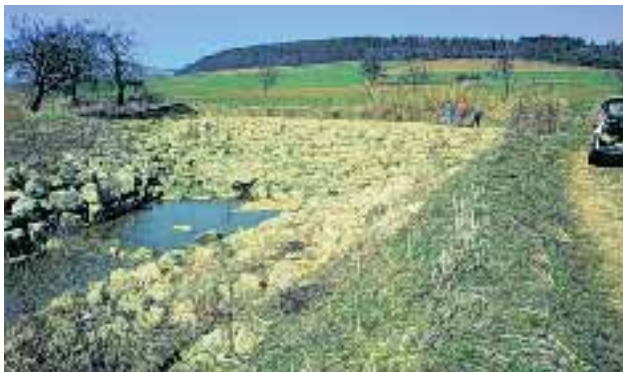
Abb. 2.11: Trockenfallen einer Setzsteinrampe bei Niedrigwasser. Der Abfluss findet hier momentan in den Zwischenräumen des Deckwerkes statt. Eine Durchwanderbarkeit für Fische ist in diesem Fall nicht möglich.
