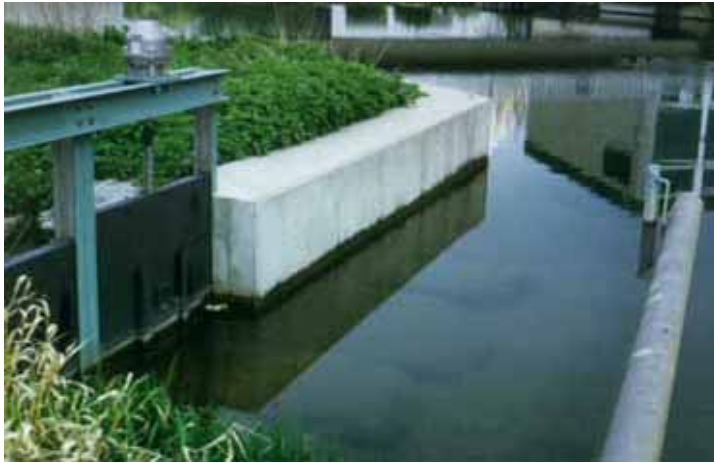
Abb. 4.22: Blick vom OW auf den Einlaufbereich mit Schwimmbalken und Regulierschütz.
