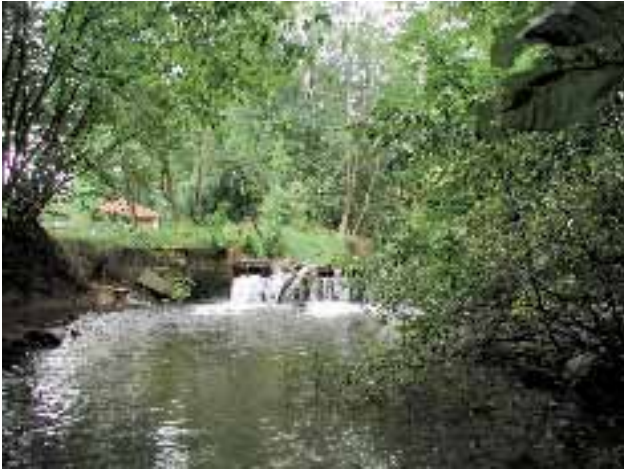
Abb. 2.163 u. 2.164: Wehranlage vor dem Umbau (vom Unterwasser): Absturzhöhe ~1,0 m.
