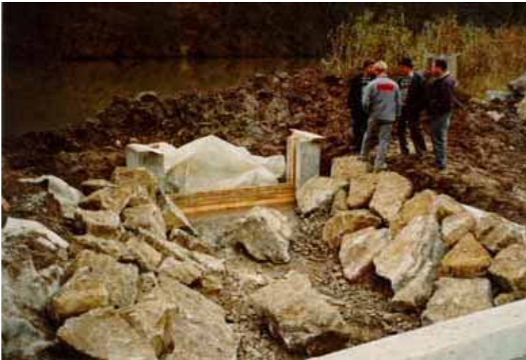
Abb. 3.67: Der oberwasserseitige Einlaufbereich im Bauzustand.
