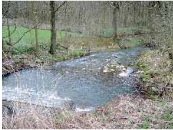
Abb. 2.160: Vor dem Umbau vorhandener Absturz (Blick ins Unterwasser).
