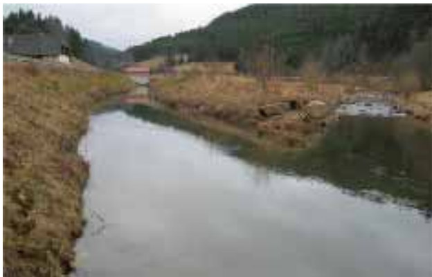
Abb. 3.31: Sackgasseneffekt in Turbinenkanälen bei Ausleitungsstrecken, hier mit Rückstau in die Ausleitungsstrecke (rechts).
