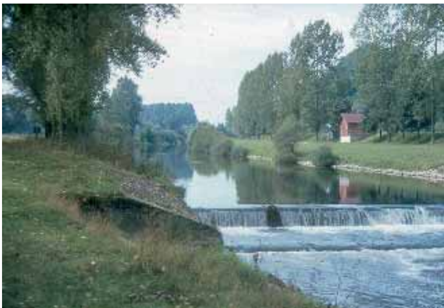
Abb. 2.137: Absturz (vor dem Umbau).
