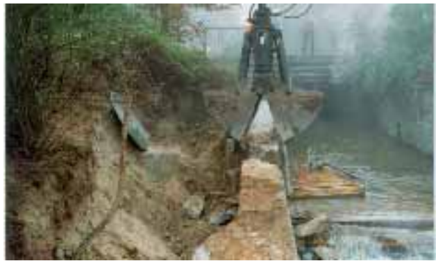
Abb. 2.170: Abbruch der bestehenden Wände.
