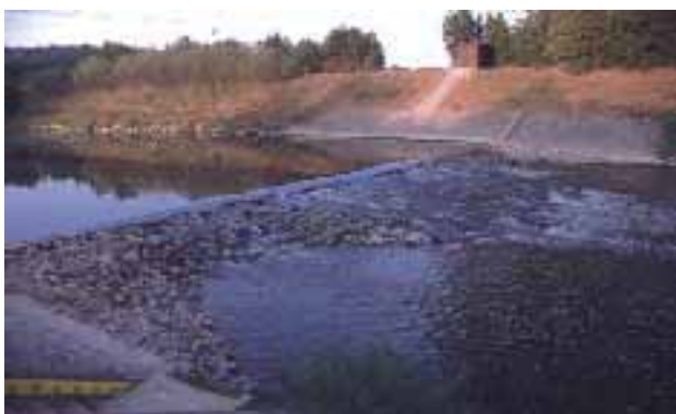
Abb. 2.18: Erweiterung einer bestehenden Pegelschwelle durch eine Muldenrampe (Aufnahme bei Niedrigwasserabfluss).
