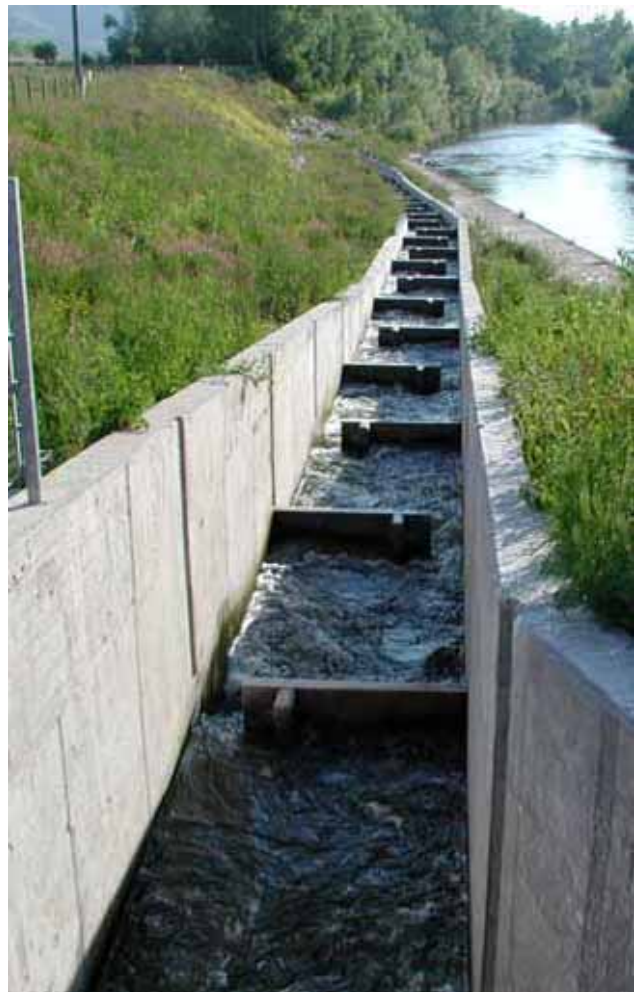
Abb. 4.81 und 4.82: Becken-Schlitz-Pass Kiebingen (links ohne, rechts mit Betriebsabfluss).
