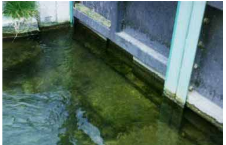
Abb. 4.23: Nahaufnahme des Einlaufbereiches mit durchgängigem Sohlenanschluss.
