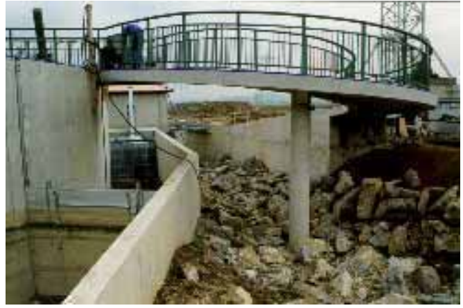
Abb. 3.118: Oberer Teil des Umgehungsgewässers im Bauzustand.
