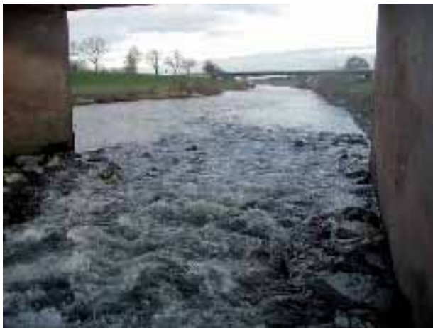
Abb. 2.121: Rampe in Betrieb, Blick nach unterstrom.
