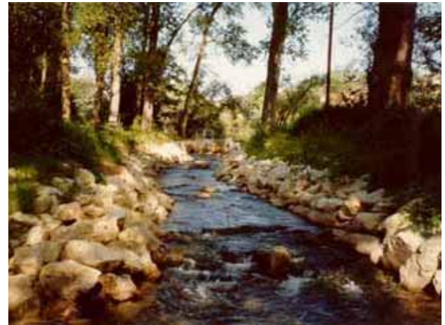
Abb. 3.64: Umgehungsgewässer direkt nach der Fertigstellung.
