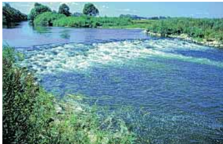
Abb. 2.153: Ansicht der Anlage.
