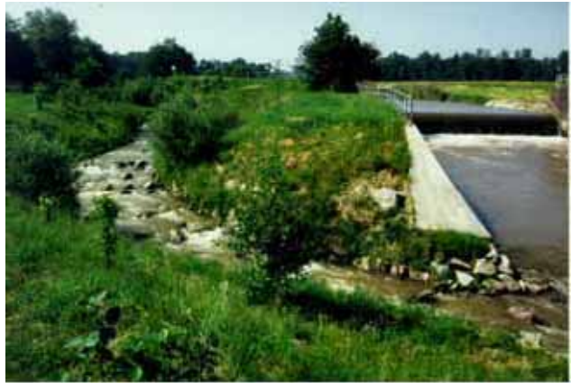
Abb. 3.39: Gesamtansicht der Anlage vom UW.
