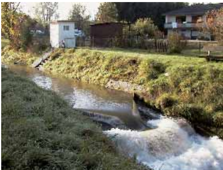
Abb. 2.196: Kaskadenförmiger Absturz (vor dem Umbau).
