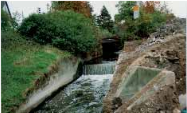
Abb. 2.169: Ursprünglicher Absturz und Auslauf des Regenüberlaufbeckens.
