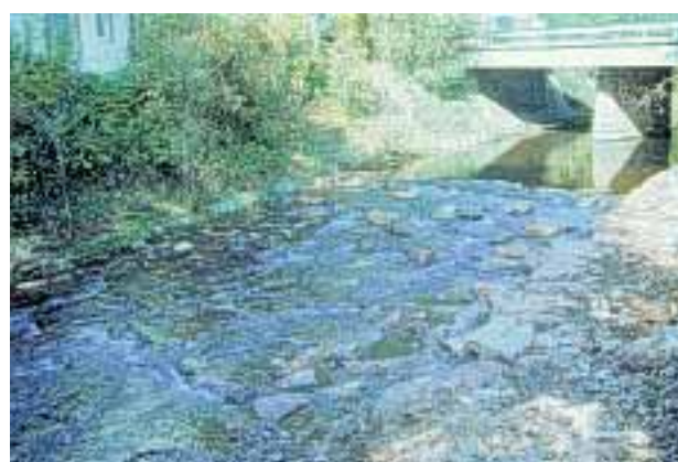
Abb. 2.144: Nach der Umgestaltung. Die Sohlenpflasterung wurde teilweise entfernt.
