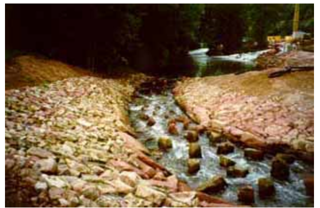
Abb. 3.115: Ansicht von OW nach UW nach Fertigstellung.
