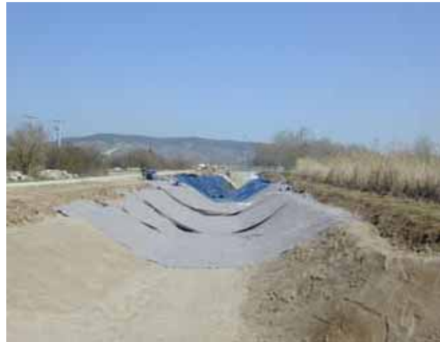
Abb. 4.71: Sandunterlage, Flies und PE-HD- Folie.
