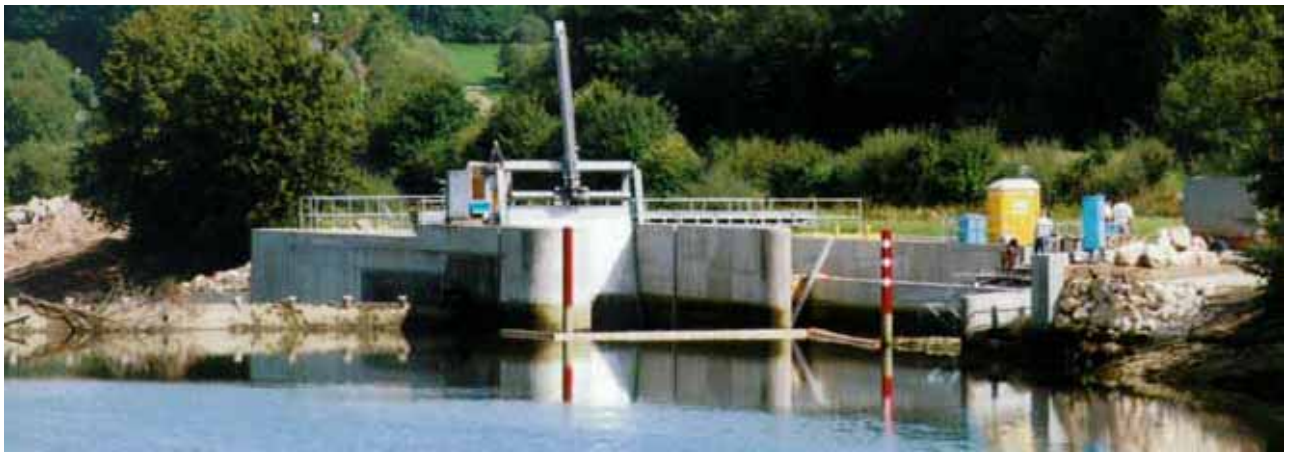
Abb. 3.85: Aufnahmen vom Bauzustand der Anlage.
