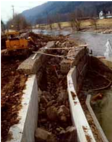
Abb. 4.40 und 4.41: Abschnitt des Kombinationsgewässers im beengten Umfeld unterhalb der Wasserkraftanlage im Bau und nach Fertigstellung.
