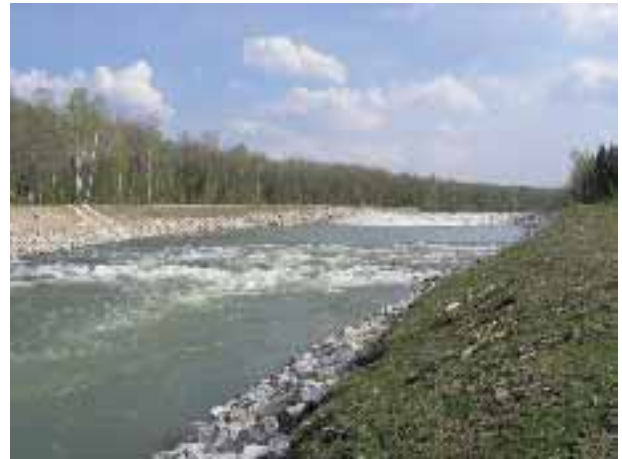
Abb. 2.135: Ansicht der fertiggestellten Rampe.
