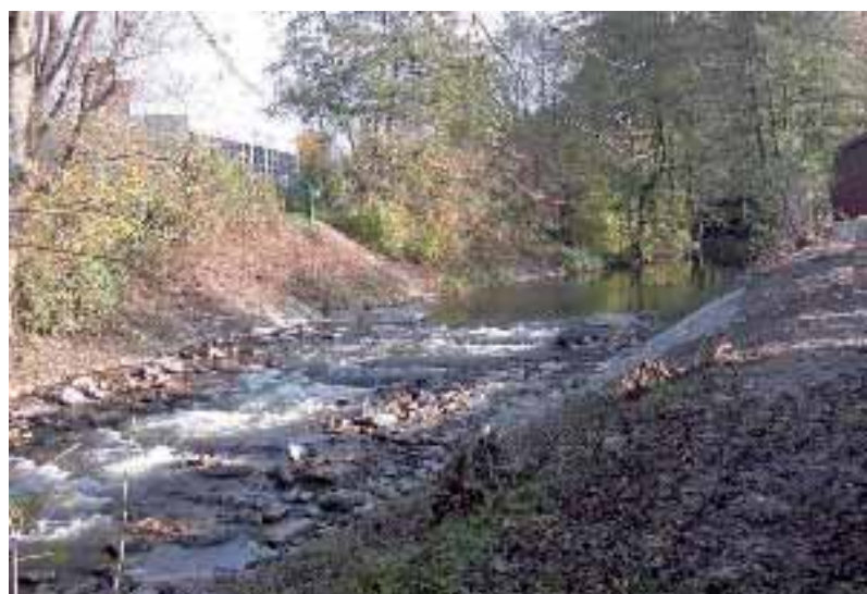
Abb. 2.195: Riegelrampe.
