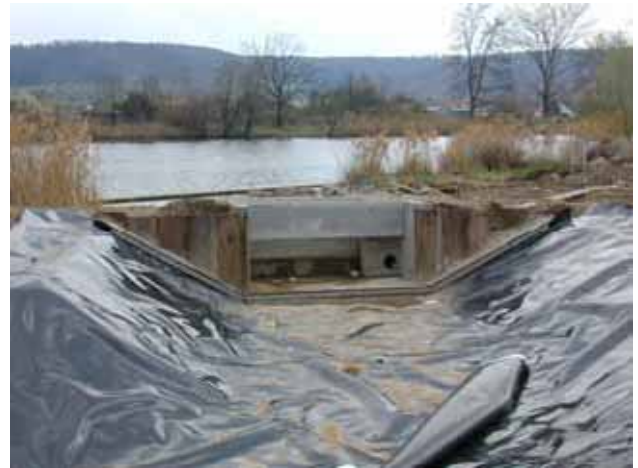
Abb. 4.73: Anschluss der Dichtungsfolie am Einlaufbauwerk.
