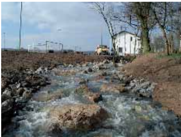
Abb. 2.192: Fertige Rampe vom Unterwasser.
