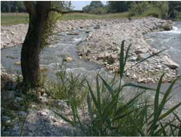
Abb. 3.56: Auslaufbereich direkt nach der Fertigstellung.
