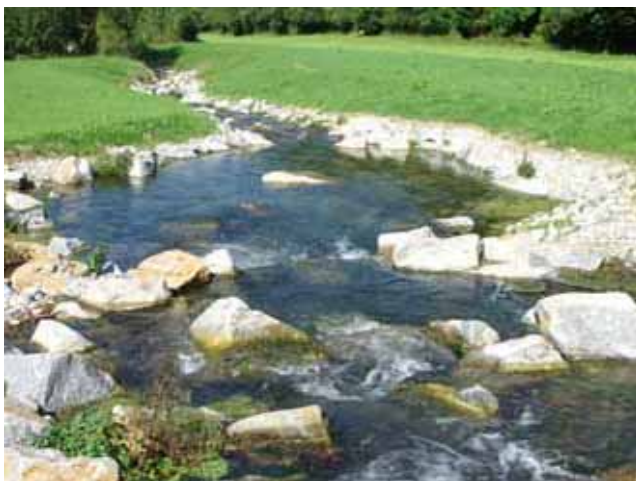
Abb. 3.76 u. 3.77: Naturnahes Umgehungsgewässer Gottrazhofen: unterer Abschnitt mit Gumpen (links) und mittlerer Abschnitt mit typischer Störsteinanordnung (rechts).
