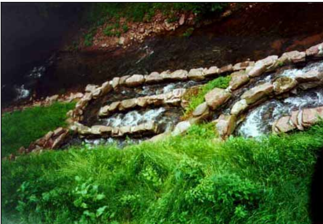
Abb. 3.110: Draufsicht auf das Umgehungsgewässer.
