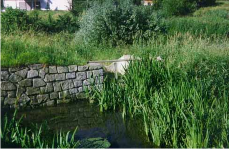
Abb. 3.98: Blick von OW zum Einlaufbereich.
