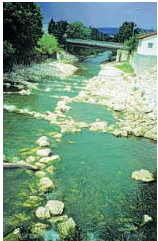
Abb. 2.178: Ansicht ins Unterwasser.
