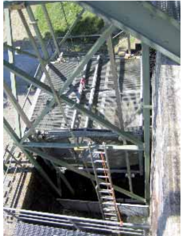
Abb. 1.7: Transportbehälter des Fischlifts.
