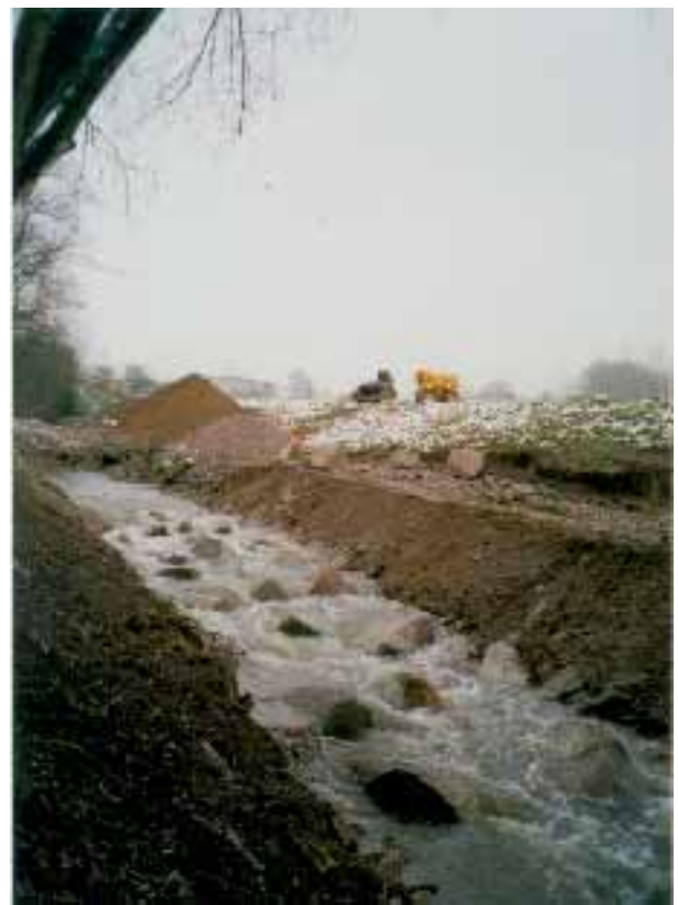
Abb. 2.125: Fertige Sohlenrampe flussaufwärts gesehen.
