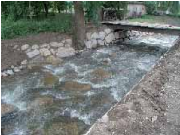
Abb. 2.130: Rampe in Betrieb, Blick nach unterstrom.
