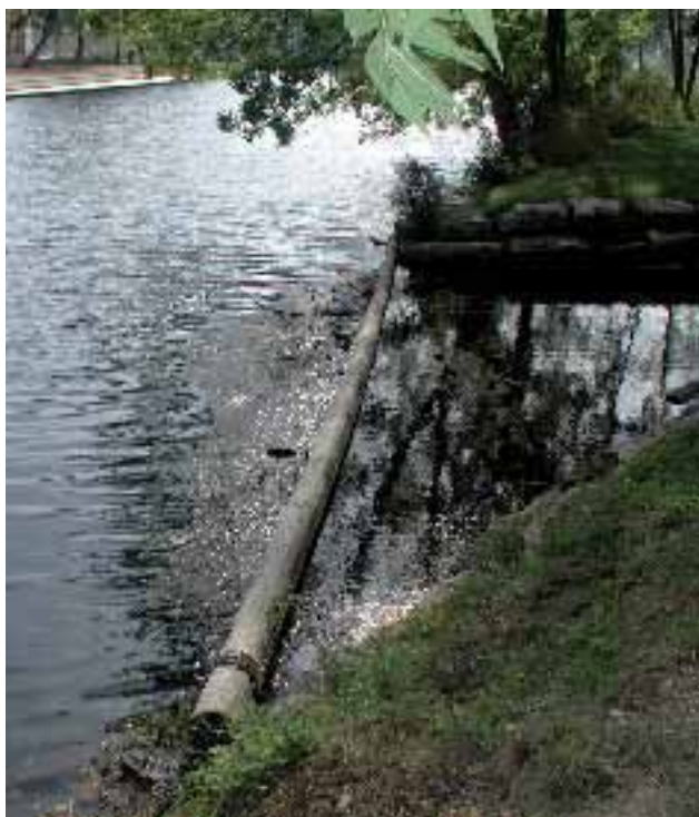
Abb. 3.22: Schwimmbalken aus Holz
