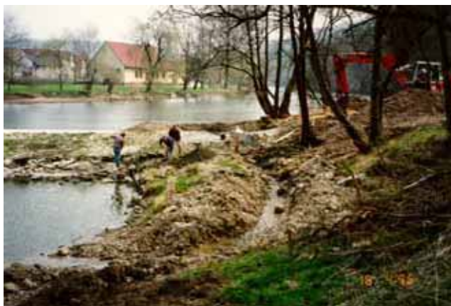
Abb. 3.47: Das Umgebungsgewässer im Bauzustand vom unterwasserseitigen Ufer aus aufgenommen.
