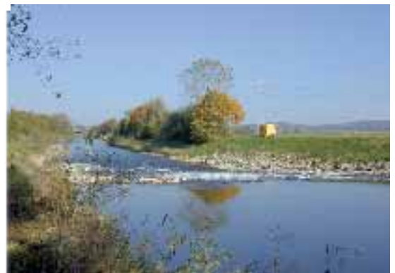
Rampe nach der Fertigstellung, von Oberwasser
