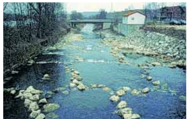
Abb. 2.17: Ausführungsbeispiel mit Anordnung der Riegel in Gitterstruktur.
