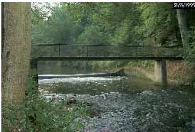
Abb. 2.212: Absturz vor dem Umbau.
