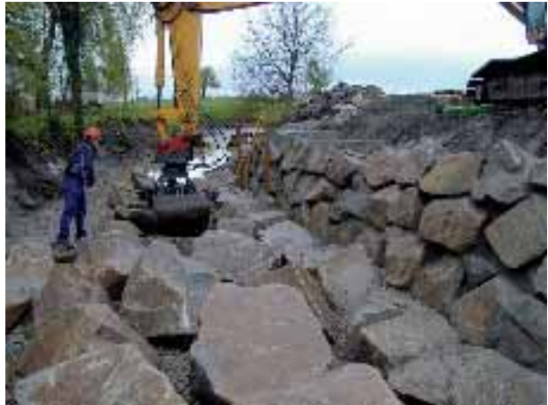
Abb. 2.129: Bauphase, Setzen der Störsteine.
