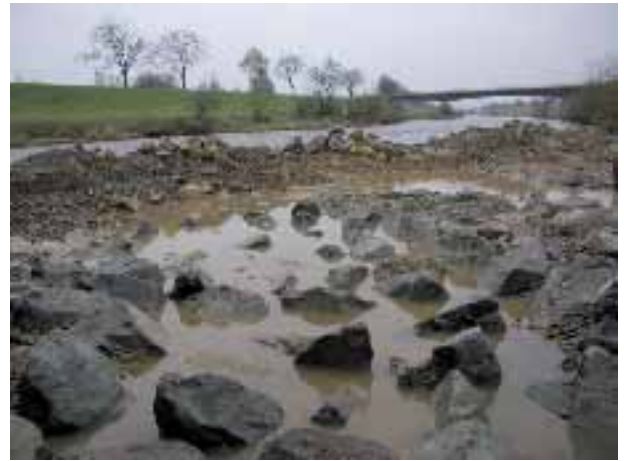
Abb. 2.118: Niedrigwasserrinne im Bauzustand.
