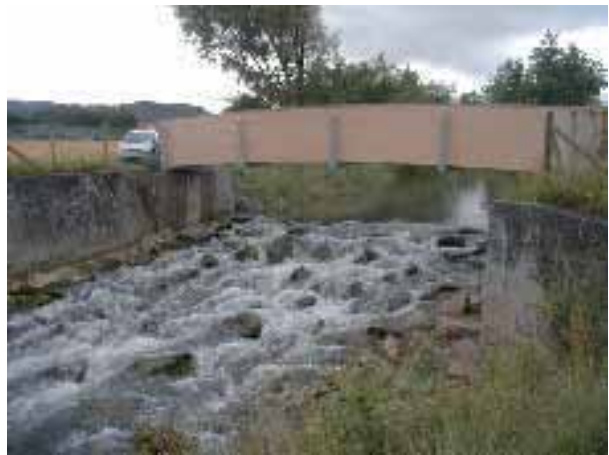
Abb. 2.100: Blick vom Unterwasser nach Fertigstellung.
