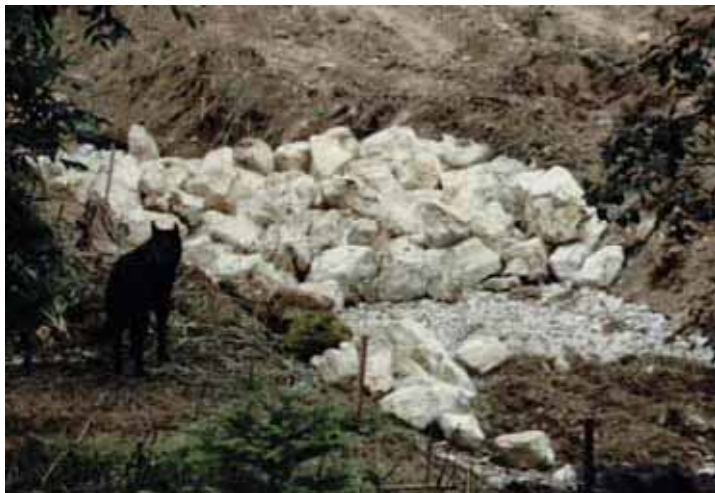
Abb. 4.52: Anlage im Bauzustand. Einbringung der Steinschüttung auf eine Kieslage.
