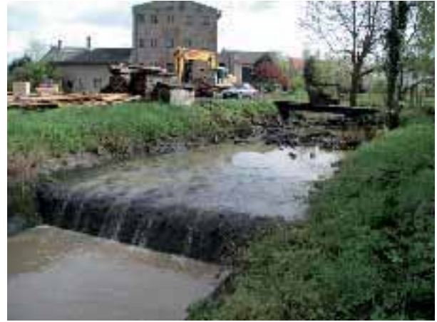
Abb. 2.127: Absturz vor dem Abbruch.
