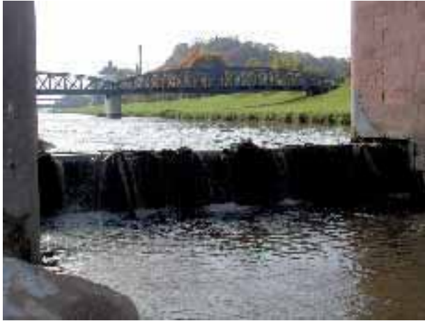
Abb.: 2.117: Bestehende Wehranlage (linkes Wehrfeld).
