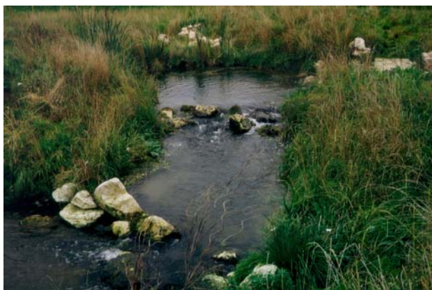
Abb. 3.30: Durchströmte Querriegel.
