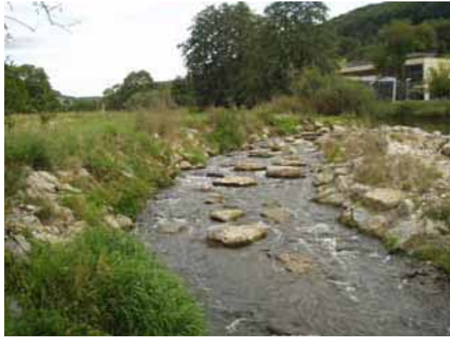
Abb. 3.57: Blick vom Unterwasser, ca. 1 Jahr nach der Fertigstellung.
