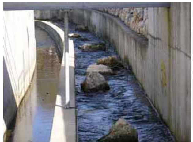
Abb. 4.18: Wasserkraftanlage Laiz/Sigmaringen, Aufnahme von OW.
