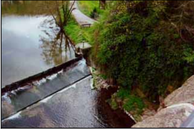
bb. 3.107: Blick auf Wehrklappe vor Bau.
