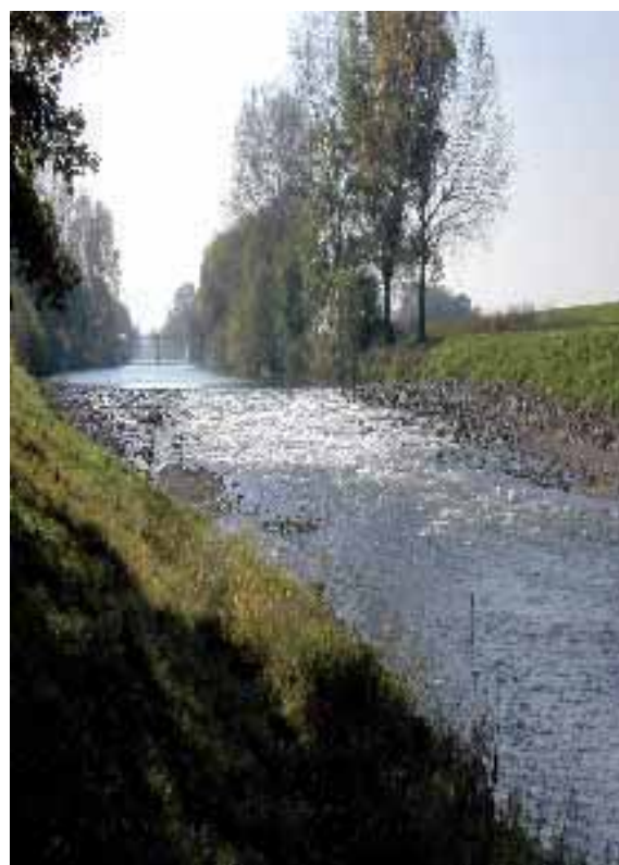
Abb. 2.79 und 2.80: Der Zustand der Sohlenschwelle vor und nach dem Umbau zu einer Rauen Rampe.
