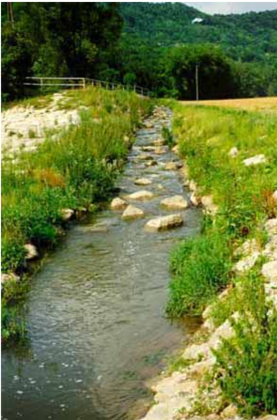
Abb. 3.69: Blick von UW in das Umgehungsgewässer.
