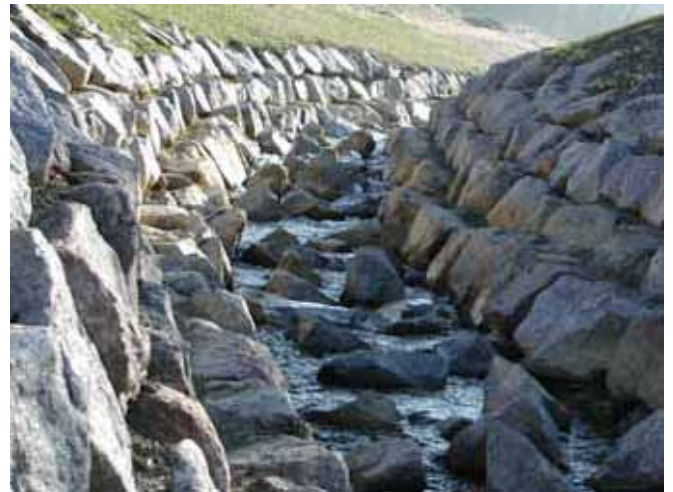
Abb. 3.74 u. 3.75: Unterer Abschnitt des naturnahen Umgehungsgewässers Gottrazhofen: Bauzustand (links) und direkt nach der Inbetriebnahme (rechts).
