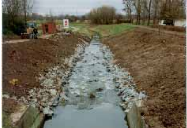
Abb. 2.172: Fertige Sohlenrampe flussabwärts gesehen.
