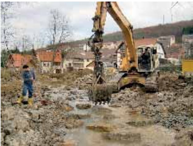
Abb. 2.165: Rampe im Bau (Versetzen der Störsteine).
