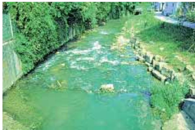
Abb. 2.112: Ansicht vom Oberwasser.
