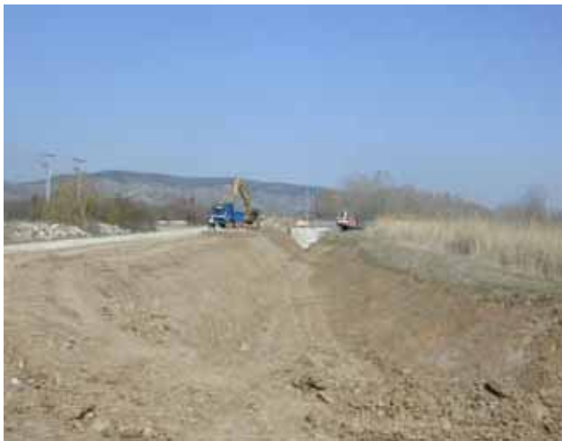
Abb. 4.70: Nach dem Aushub, beim Einbringen des Sandes.
