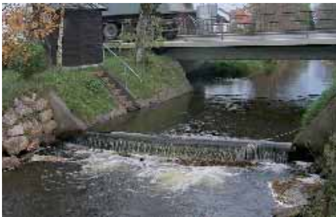
Abb. 2.173: Absturz (vor dem Umbau).
