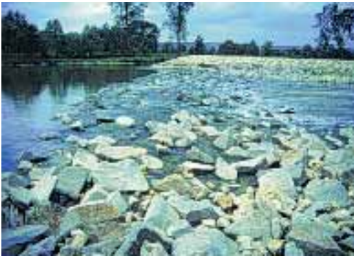
Abb. 2.154: Ansicht der Anlage.
