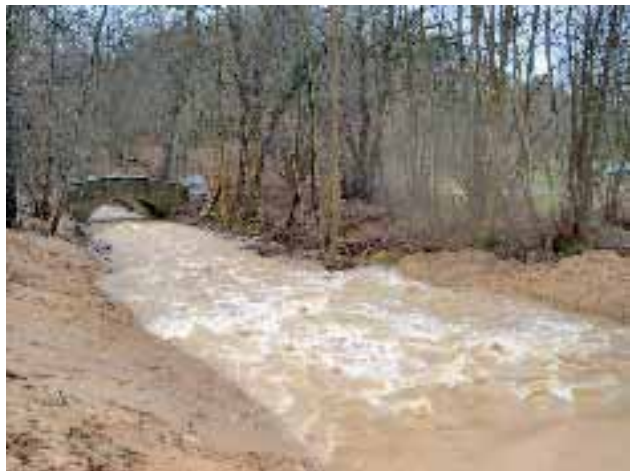
Abb. 2.166: Rampe unmittelbar nach der Fertigstellung bei kleinerem Hochwasser.
