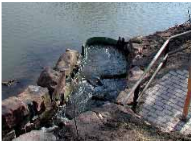
Abb. 3.21: Halbkreisförmige Tauchwand am Einlauf eines Umgehungsgewässers.
