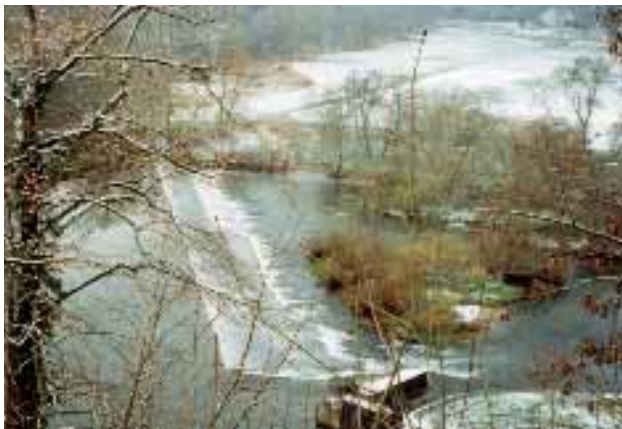
Abb. 2.208 und 2.209: Ansicht des Wehres vom rechten Ufer vor und nach der Umgestaltung. Die Niedrigwasserrinne verläuft entlang des Ufers. Die seitliche Anrampung verbindet die eigentliche Rampe mit dem Wehrrücken.
