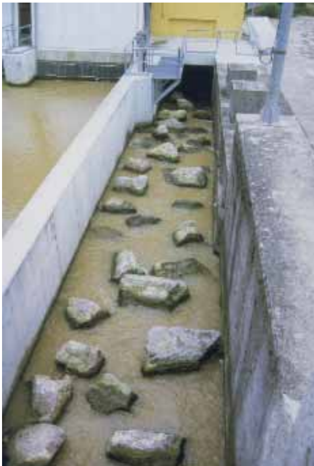
Abb. 3.11: Der Rechteckquerschnitt aus Beton wurde mit Störsteinen und Sohlensubstrat ausgebaut.
