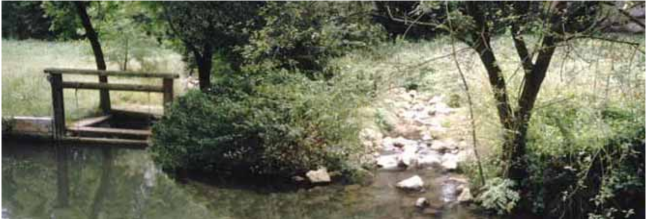
Abb. 4.55: Blick auf den oberwasserseitigen Einlaufbereich mit Wehranlage ca. 1 Jahr nach Fertigstellung. Eine Reihe Steinriegel kontrolliert den Abfluss.
