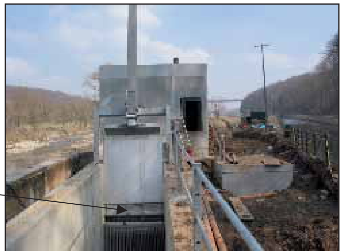
Abb. 3.128: Ansicht Rechen und Schachtbauwerk.
