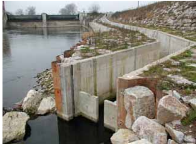
Abb. 4.80: Einstieg in den Becken-Schlitz-Pass Kiebingen.
