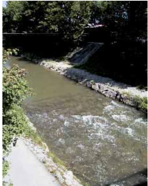
Abb. 2.140: Setzsteinrampe.
