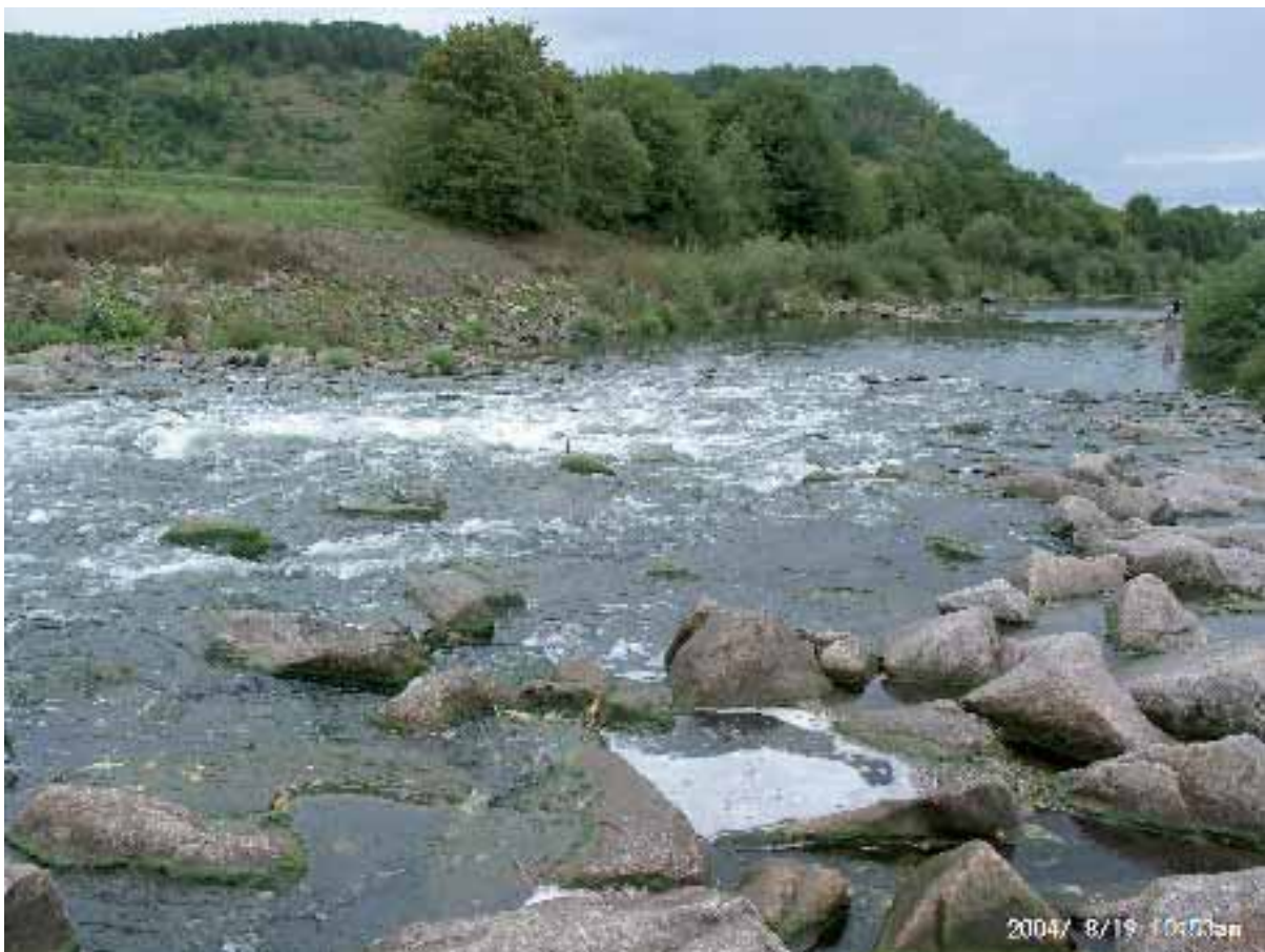
Abb. 2.87 und 2.88: Die Anlage fünf Jahre nach Fertigstellung.
