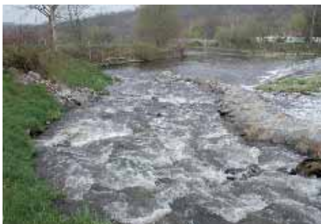
Abb. 2.66: Teilrampe vom Oberwasser aus.
