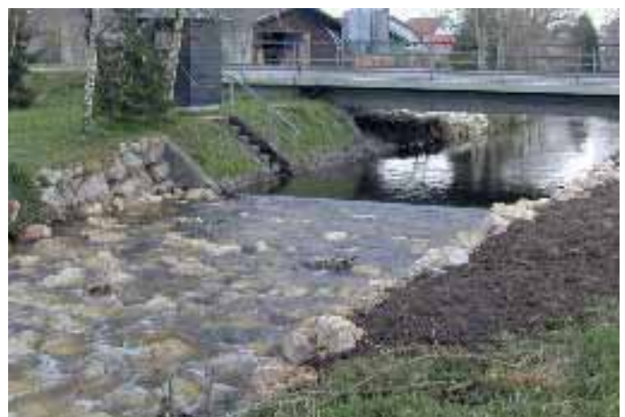
Abb. 2.174: Schüttsteinrampe.
