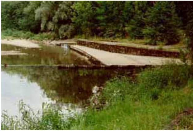
Abb. 3.61: Mündungsbereich der Autmut in den Neckar vor der Maßnahme.
