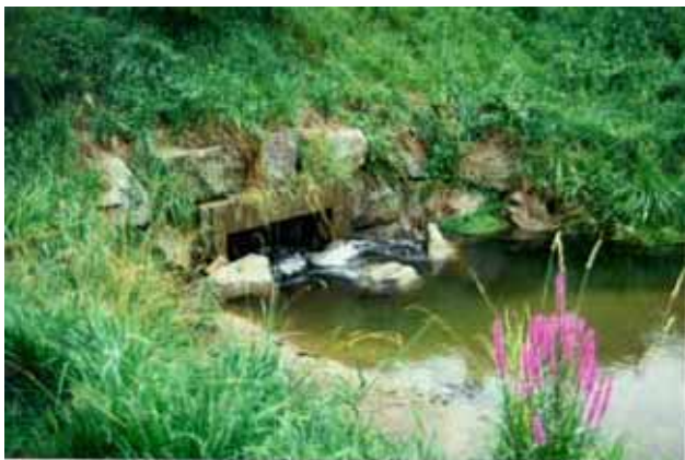
Abb. 3.41: Blick auf das oberwasserseitige Einlaufbauwerk (Querung des HW-Dammes). Eine Steinriegelreihe kontrolliert den Abfluss.
