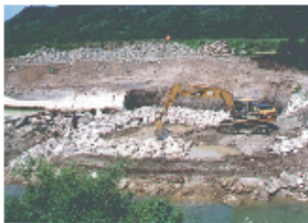
1. Querriegel nach der Endschwelle am Tosbecken
