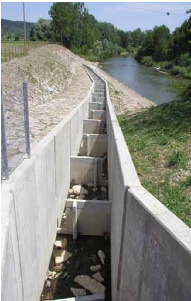
Abb. 4.81 und 4.82: Becken-Schlitz-Pass Kiebingen (links ohne, rechts mit Betriebsabfluss).
