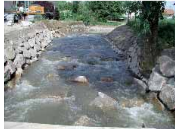
Abb. 2.131: Rampe in Betrieb, Blick nach oberstrom.
