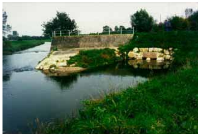
Abb. 3.42: Blick vom OW auf das Wehr am Renchflutkanal. Rechts ist der Einlaufbereich zu erkennen.
