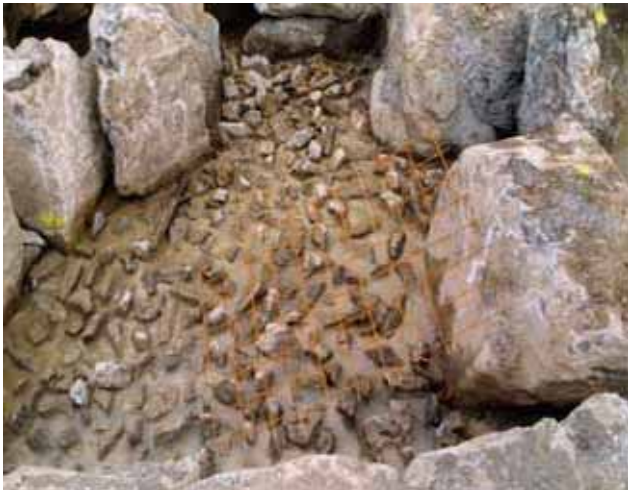
Abb. 4.85: Einbau der Wasserbausteine zwischen den Riegeln in den noch plastischen Beton der Bodenplatte.
