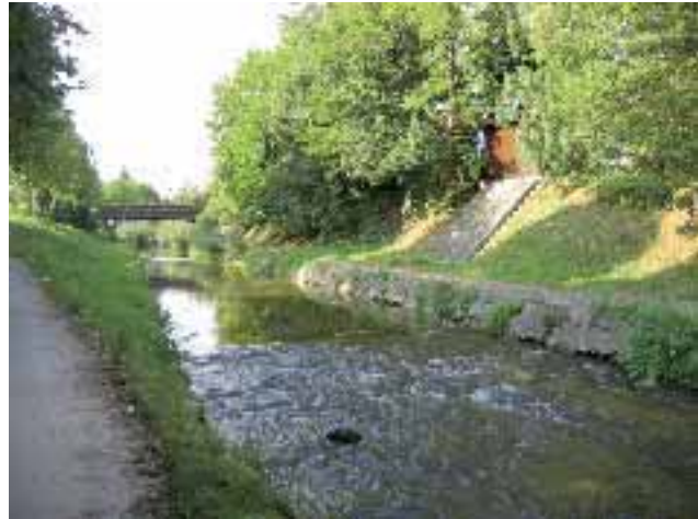
Abb. 2.72: Rampe am Pegel Rotach bei Friedrichshafen.
