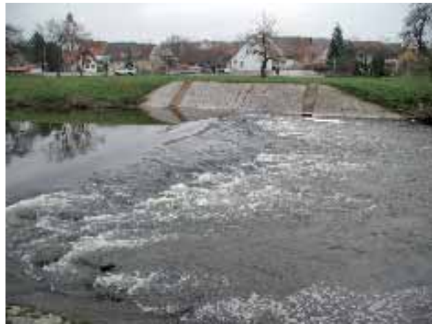
Abb. 2.19: Muldenrampe bei mittlerem Wasserstand.
