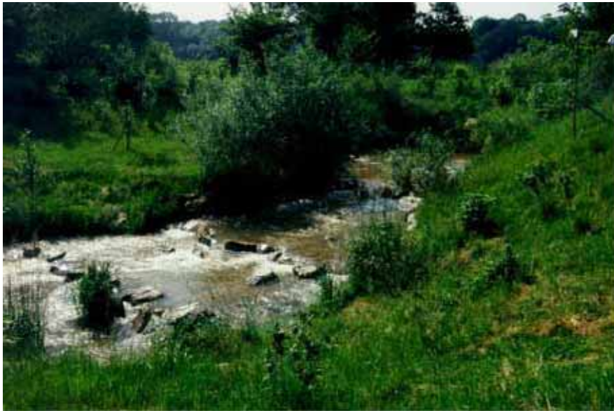
Abb. 3.44: Blick auf das Umgehungsgewässer ca. 4 Jahre nach der Fertigstellung.
