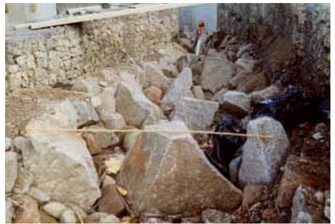
Abb. 4.39: Herstellung Steinriegel.
