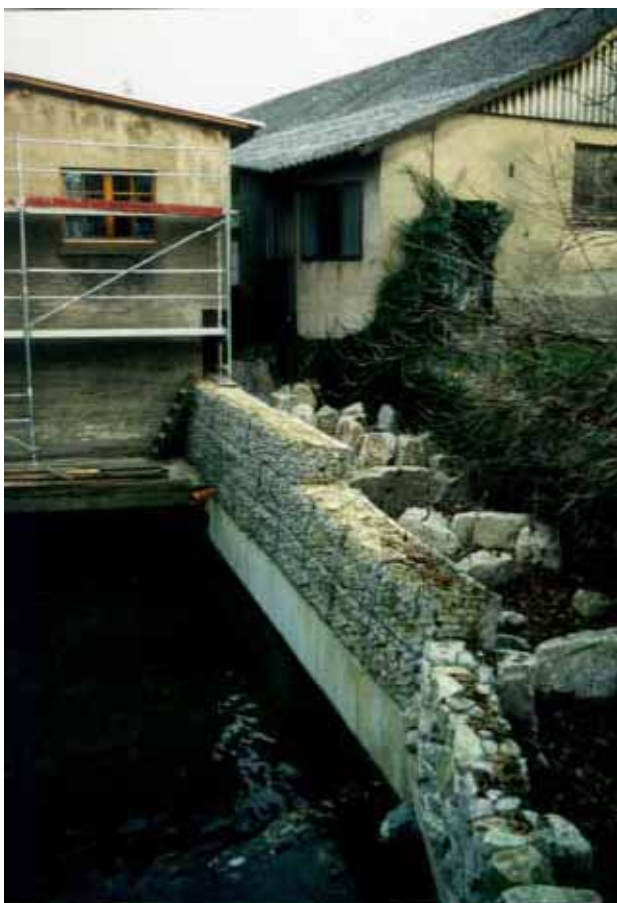
Abb. 3.106: Die Anlage während der Bauphase.
