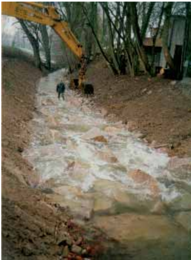
Abb. 2.124: Versetzen der Störsteine.
