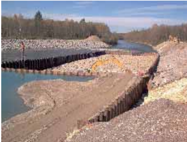
Abb. 2.134: Linke Rampenhälfte während der Bauphase.
