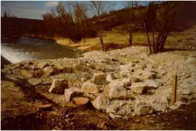
Abb. 3.54: Blick vom Oberwasser – Bauzustand.
