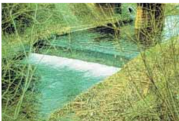
Abb. 2.143: Vor der Umgestaltung mit Sohlenpflasterung.
