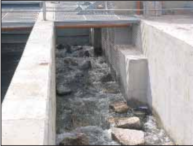
Abb. 3.123: Oberer Teil nach Einlauf.f
