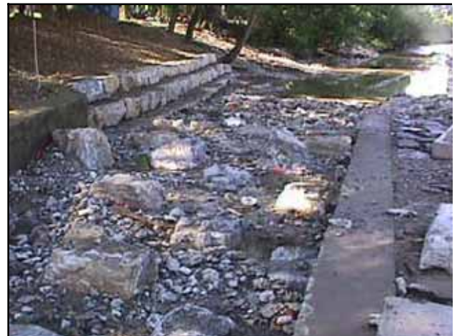
Abb. 4.61: Blick in das Gerinne Richtung Unterwasser.
