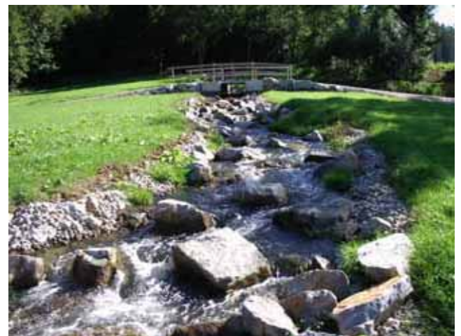
Abb. 3.76 u. 3.77: Naturnahes Umgehungsgewässer Gottrazhofen: unterer Abschnitt mit Gumpen (links) und mittlerer Abschnitt mit typischer Störsteinanordnung (rechts).
