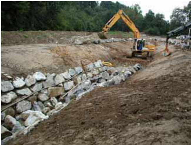
Abb. 3.74 u. 3.75: Unterer Abschnitt des naturnahen Umgehungsgewässers Gottrazhofen: Bauzustand (links) und direkt nach der Inbetriebnahme (rechts).
