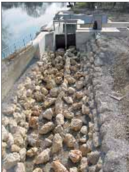
Abb. 3.135: Verbaugrad nach Einlauf.
