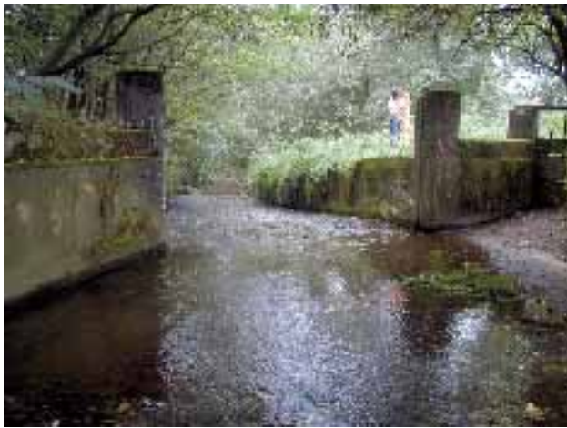
Abb. 2.190: Alte Wehranlage vom Oberwasser.
