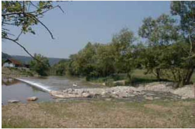
Abb. 3.55: Wehranlage mit Umgebungsgewässer direkt nach der Fertigstellung.
