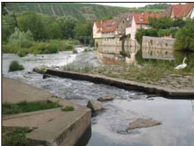
Abb. 4.62: Fließbild Blick von Oberwasser nach Unterwasser.
