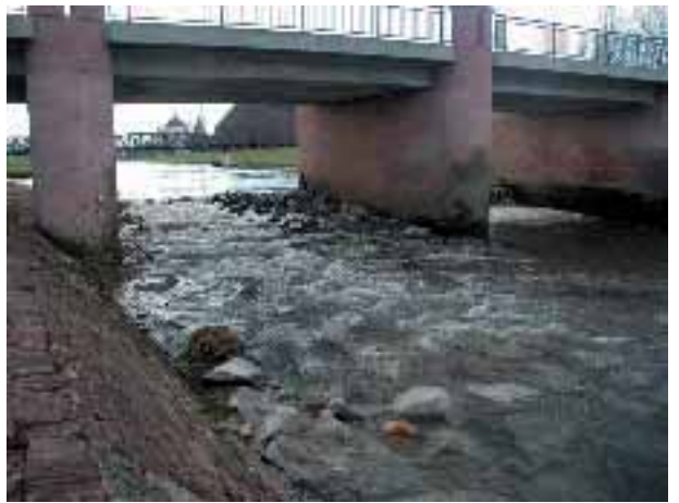
Abb. 2.120: Rampe in Betrieb, Blick nach oberstrom.
