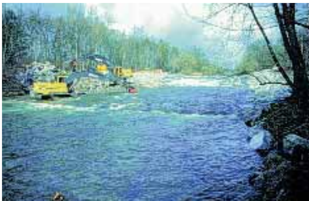
Abb. 2.7: Bau einer Schüttsteinrampe in fließender Welle.
