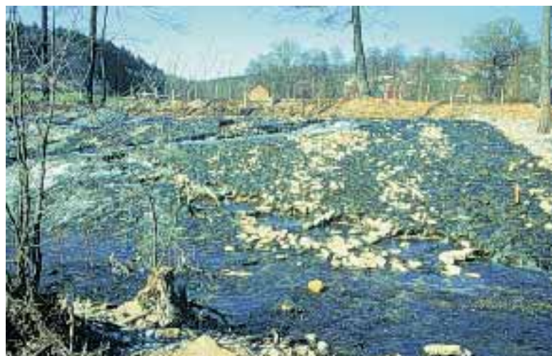
Abb. 2.103: Ansicht vom Unterwasser.
