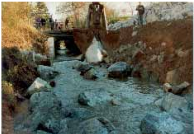
Abb. 2.171: Setzen der Störsteine.
