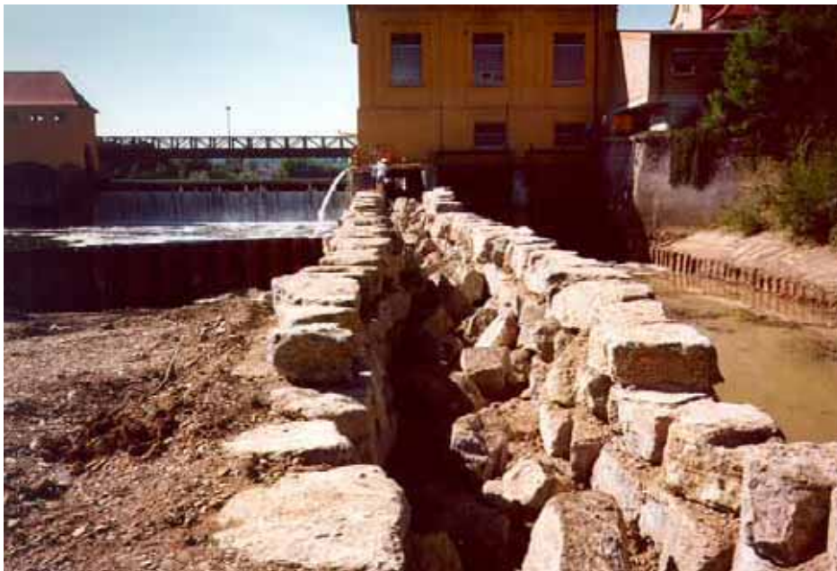
Abb. 3.94: Ansicht der Anlage vom UW im Bauzustand.
