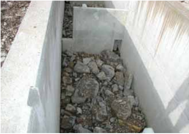
Abb. 4.79: Becken des Becken-Schlitz-Passes mit typischer Trennwand und Sohlensubstrat.
