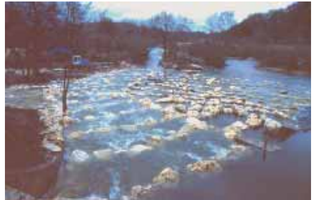
Abb. 2.207: Rampe nach Fertigstellung. Rechts unten ist die Klappe erkennbar, über die während der Hauptaufstiegszeit der Abfluss erhöht wird.
