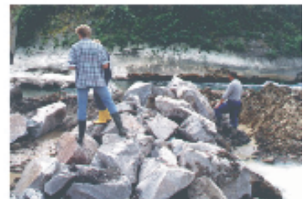
Teilweise fertiggestellter Querriegel
