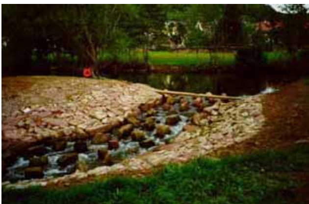
Abb. 3.114: Einlaufbereich nach der Fertigstellung.
