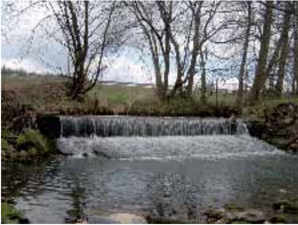
Abb. 2.159: Vor dem Umbau vorhandener Absturz .
