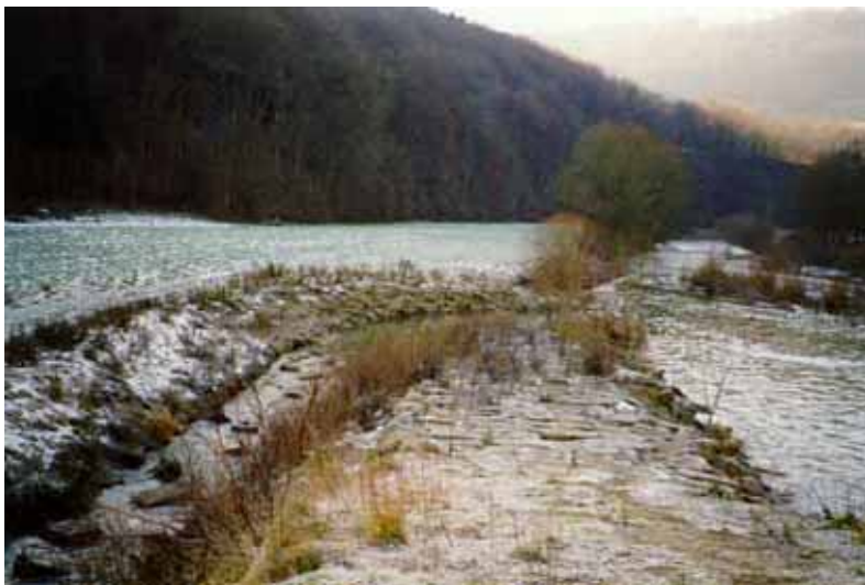
Abb. 3.73: Blick nach UW: Links liegt das Umgehungsgewässer, rechts befindet sich die Wehranlage.
