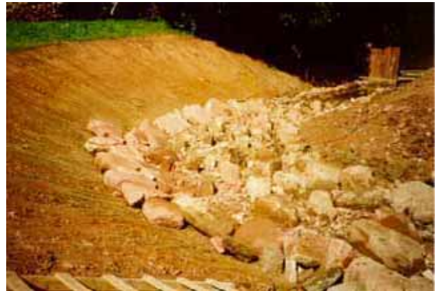
Abb. 3.113: Ansicht von OW nach UW im Bauzustand.
