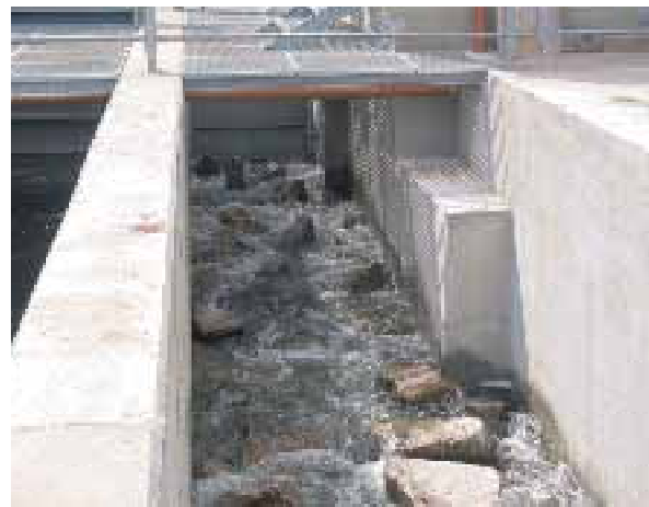
Abb. 3.2: Umgebungsgewässer mit betoniertem Regelquerschnitt und eingesetzten Störsteinen zur Strömungsauflockerung.
