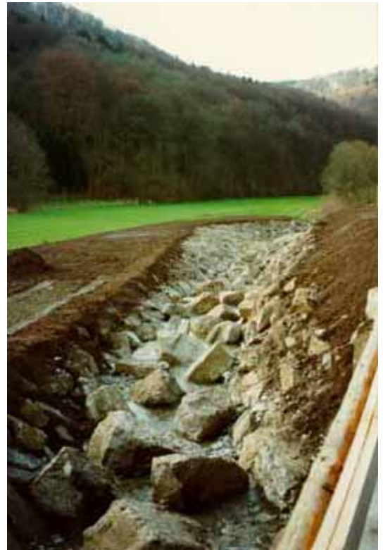
Abb. 3.68: Umgehungsgewässer im Bauzustand.
