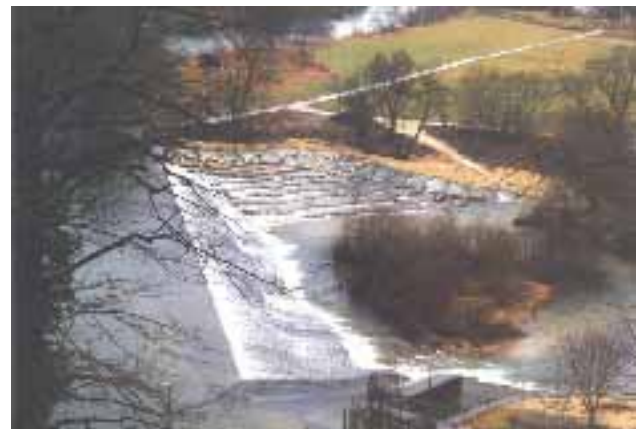
Abb. 2.208 und 2.209: Ansicht des Wehres vom rechten Ufer vor und nach der Umgestaltung. Die Niedrigwasserrinne verläuft entlang des Ufers. Die seitliche Anrampung verbindet die eigentliche Rampe mit dem Wehrrücken.
