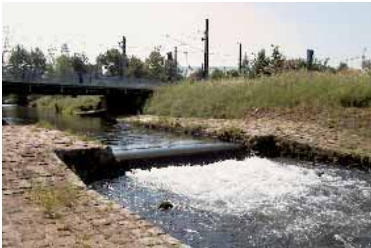
Abb. 2.210: Absturz vor dem Umbau.
