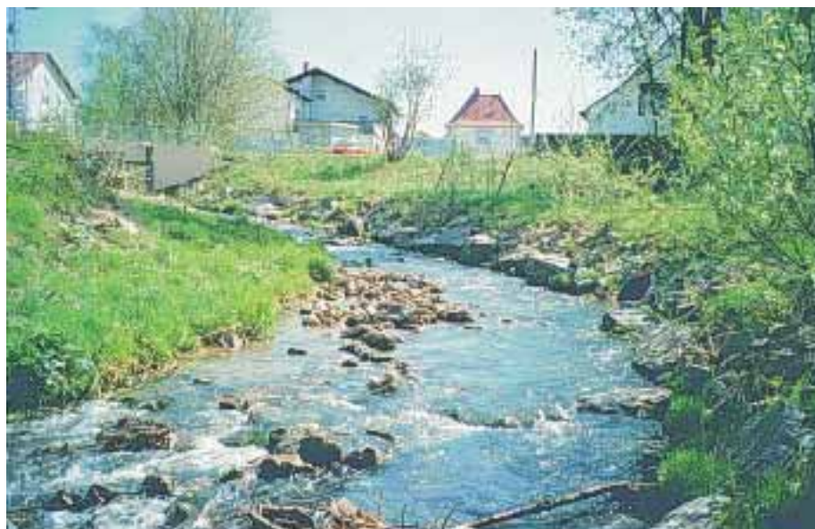
Abb. 2.89: Die Rampe vom Unterwasser aufgenommen.
