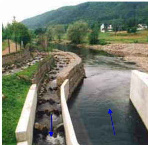
Abb. 4.40 und 4.41: Abschnitt des Kombinationsgewässers im beengten Umfeld unterhalb der Wasserkraftanlage im Bau und nach Fertigstellung.
