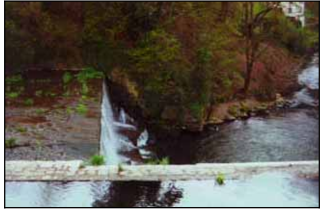
Abb. 3.108: Blick auf Wehrabsturz und Talhang Urzustand.
