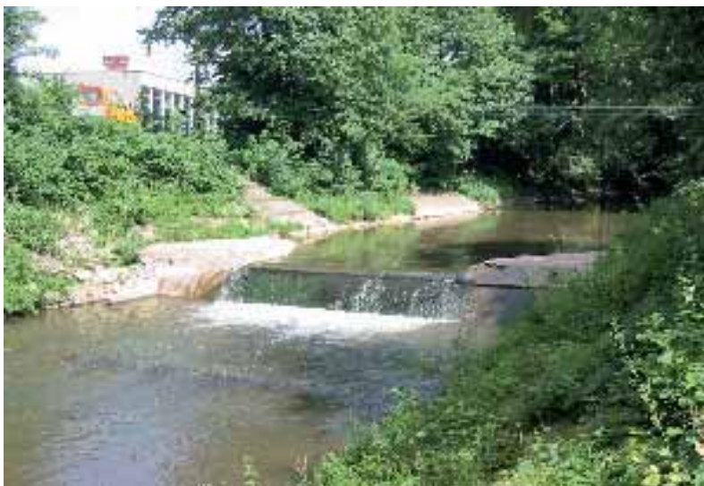
Abb. 2.194: Absturz (vor dem Umbau).
