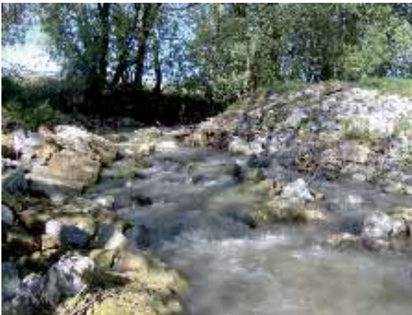
Abb. 2.161: Fertige Rampe mit Geschwemmseleintrag.
