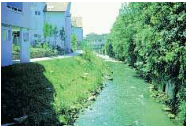
Abb. 2.111: Ansicht vom Unterwasser.
