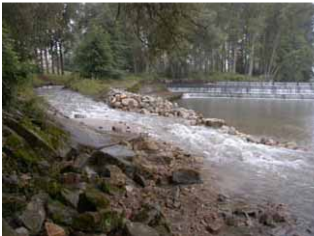
Abb. 3.65: Mündungsbereich der Autmut in den Neckar direkt nach der Fertigstellung.
