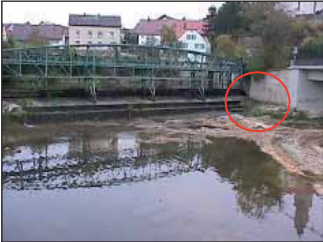
Abb. 3.130: Blick auf die historische alte Wehranlage (Kreis siehe Lageplan).
