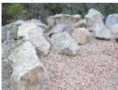
4. Setzen der Steine
