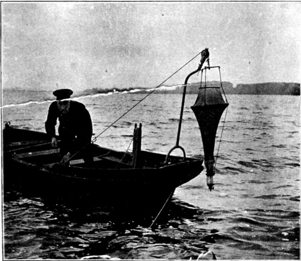
Fig. 2. Heraufholen des Planktonnetzes aus der Seetiefe.
