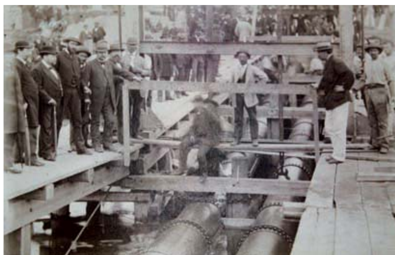
4 Düker-Rote-Hamm: Über Abwasserleitungen, Düker genannt, gelangte das Abwasser von hibdebach nach dribdebach. Stadtbaurat William Heerlein Lindley (Dritter von links) überwachte 1884 persönlich die Versenkung der Düker im Main.
