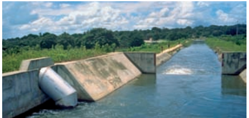
2 Bewässerungskanal: Das bei Weitem meiste Wasser geht dem blauen Wasser durch die Bewässerung von Feldfrüchten, wie hier im brasilianischen Bundesstaat Ceará, verloren. Deshalb lohnt es sich für Staaten in trockenen und halbtrockenen Klimazonen, darüber nachzudenken, ob sie nicht Nahrung aus Ländern importieren können, deren Landwirtschaft auf Regenwasser basiert.
