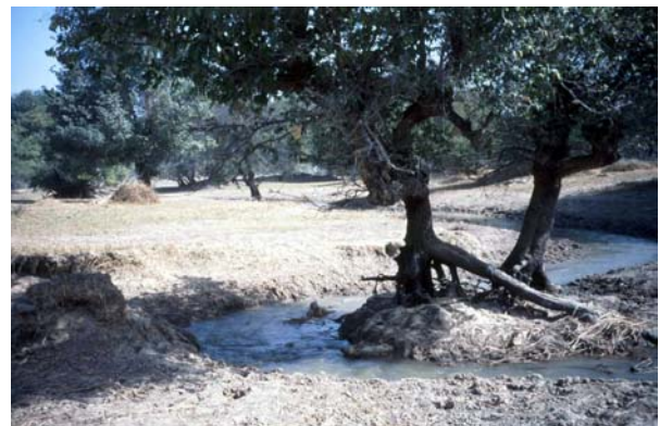
Abb. 5.17.1 und 5.17.2: Oberer flacher und unterer anthropogen vertiefter Part eines spillways im Areal Damasak Nord (Trockenzeitaufnahmen)
