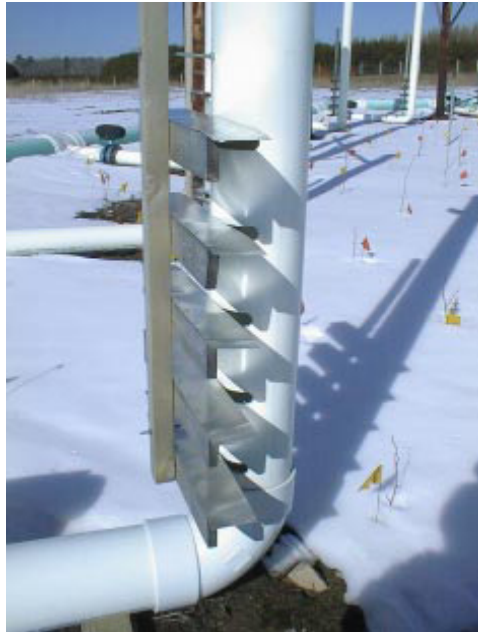
Joonis 2. Vertikaalne toru koos gaasi emiteerimise avade ja tõketega.
