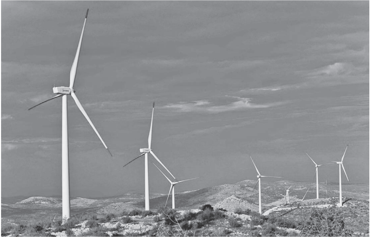
SL. 1. VJETROELEKTRANA JELINAK SMJESTENA U SPLITSKO-DALMATINSKOJ ŽUPANIJI, NA PODRUČJU OPĆINA MARINA I SEGET FIG. 1. JELINAK WIND FARM SITUATED IN THE MUNICIPALITIES OF MARINA AND SEGET, SPLIT-DALMATIA COUNTY
