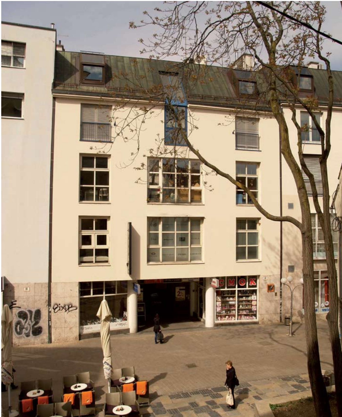
Tklačićeve ulica, detalj pročelja
