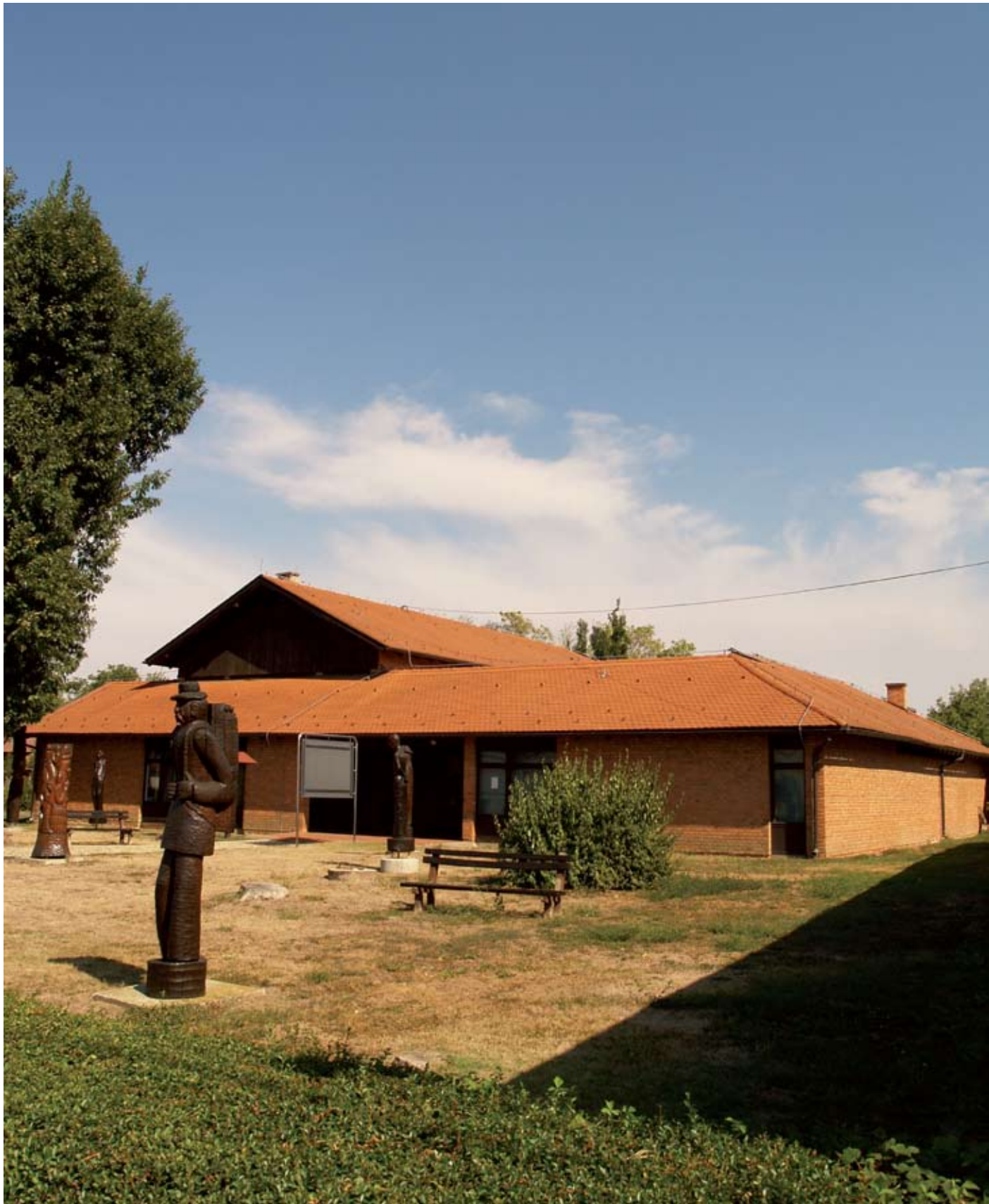
Galerije naive umjetnosti, Hlebina, ulazno pročelje
