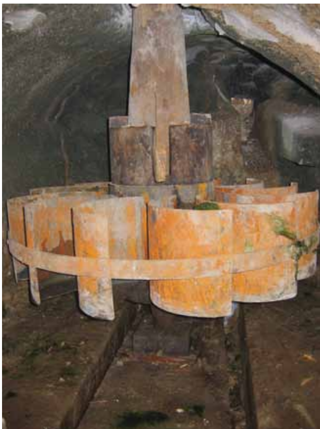
18 Ugrađeno mlinsko kolo u zasvođenom prostoru pod zgradom mlinice (foto: Sanja Buble, 2008.)
