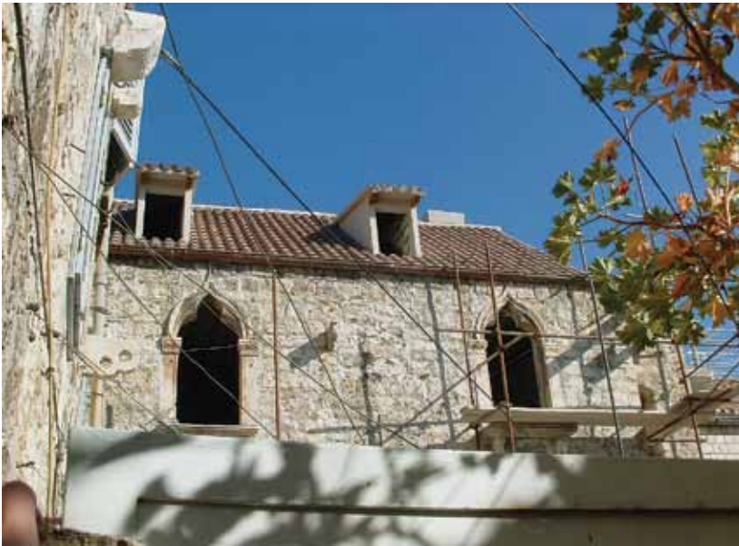
Hvar, kuća Bartučević, zapadno pročelje (foto: Anita Gamulin, 2004.)
