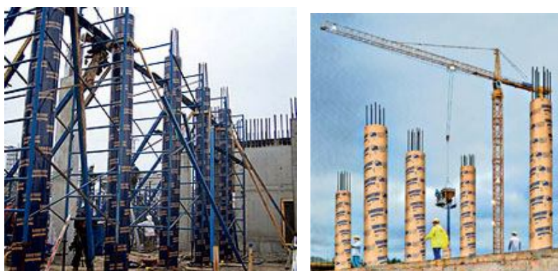
Slika 4 – Primjer korištenja recikliranog kartona u obliku oplata [11]
