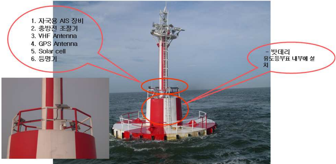
<그림 6> 부산항유도등표에 장비의 설치현황
