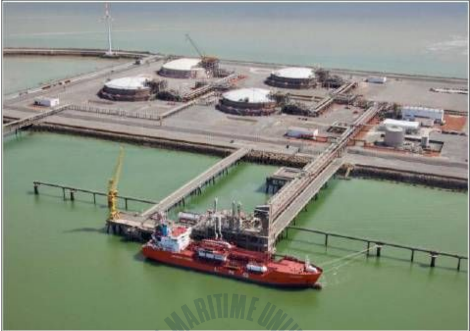
Fig. 5.13 LNG Terminal에서 선박으로 LNG충전
