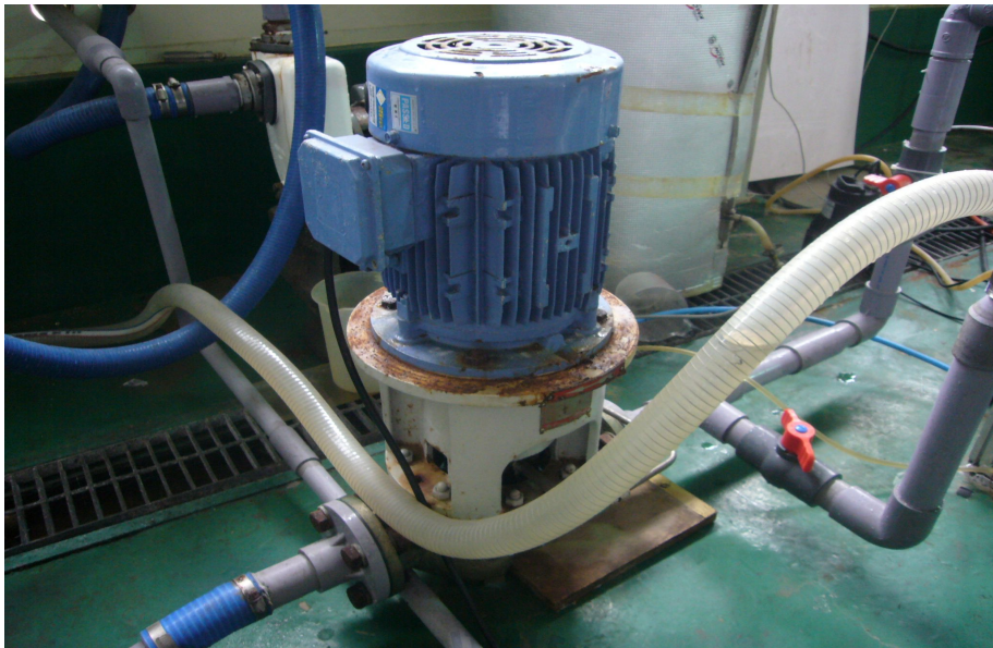
Fig. 3.21 Ejector pump
