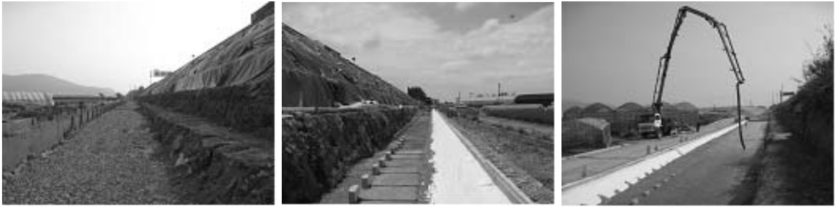
(e) 도계-초정간 도로 확장 성토(시공일시: 2008.04-30,000m 3 )
