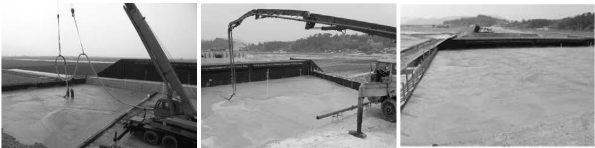
(d) 부산신항 배후도로 교대 뒷채움(시공일시: 2007.04-7,200m 3 ) (계속)
