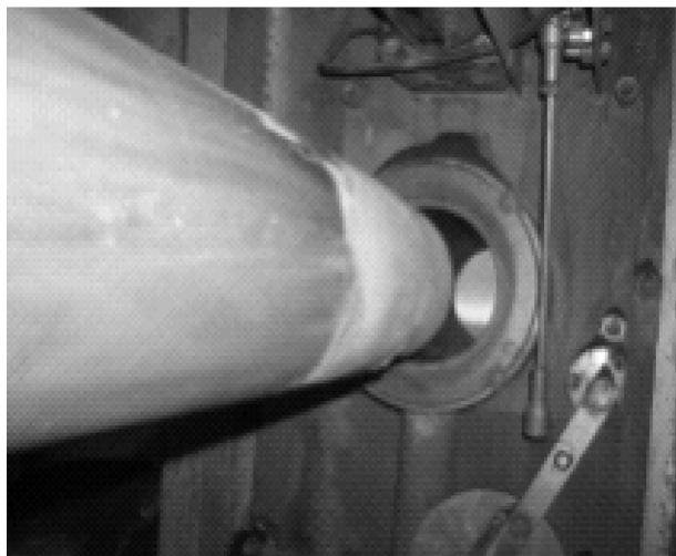
Slika 3. Kućište kamere prije uvlačenja u prostor hladnjaka klinkera
