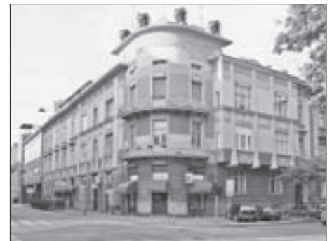
SL. 8. TRGOVAČKO-STAMBENA ZGRADA MIHELIC, PETRINJSKA 61 / HATZOVA 5, 1905./06.
