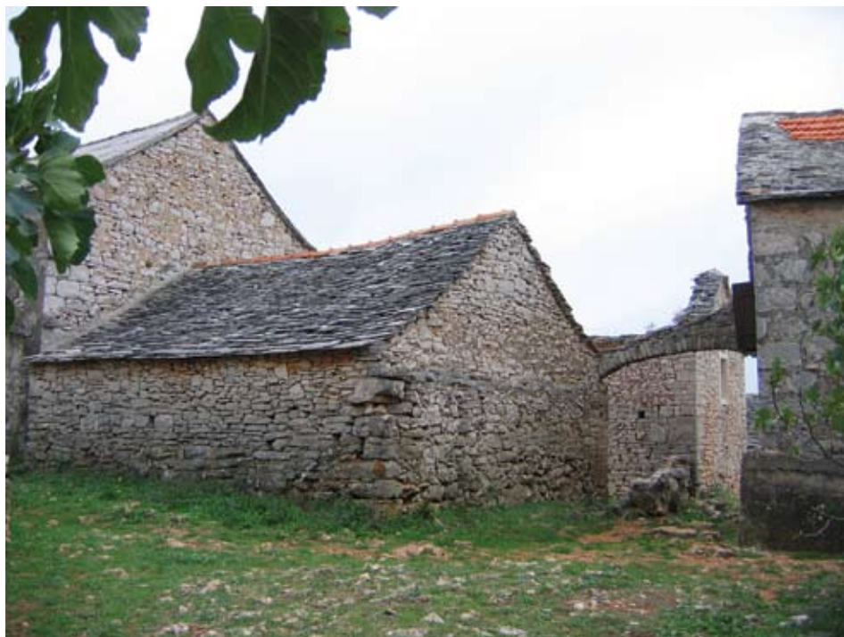
Humac na otoku Hvaru ugasio se kao sekundarno naselje Vrisničana zbog napuštanja tradicijske poljoprivrede već polovicom dvadesetog stoljeća
