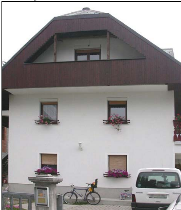
Slika 1. Zgrada u Bovcu, izgrađena od porastoga betona, preživjela je 2004. potres bez oštećenja (snimka Uroša Klemena)
