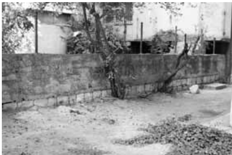
Nastavak zidane konstrukcije u dvorište susjedne zgrade
