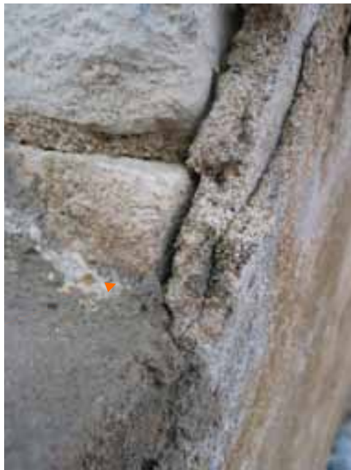
slika 6. Žbuka u sljubnici između dva kamena segmenta
