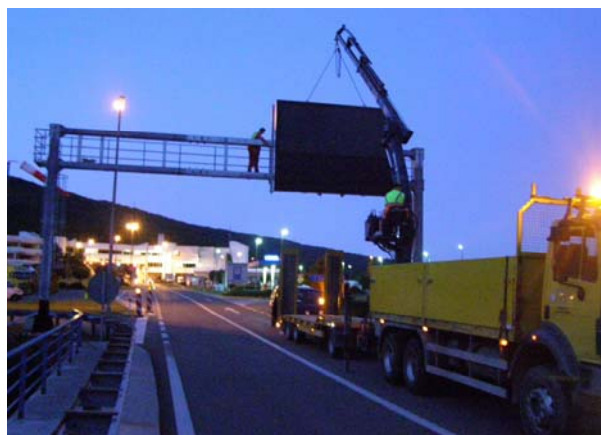
Slika 10. Montaža displeja na istarskom portalu
