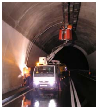
Slika 11. Radovi na 1 prometnom traku
