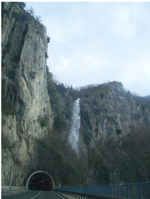
Slika 1. Ulaz u tunel Učka s istarske strane
