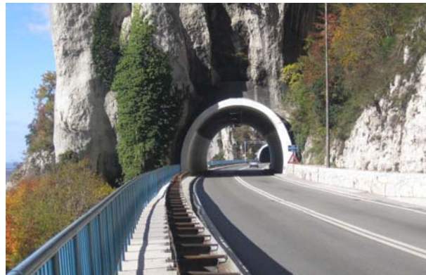
Slika 2. Tunel Zrinščak II
