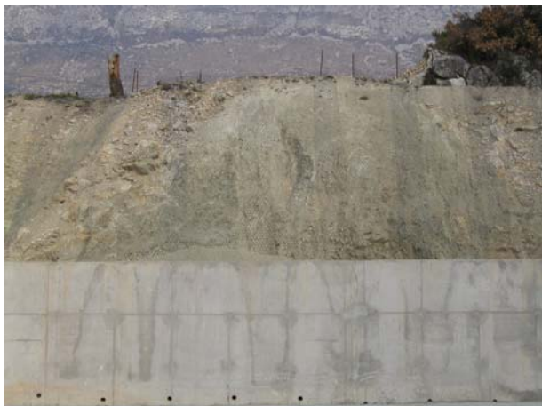
Slika 7. Usjek u masivnim laporima s lećama pješčenjaka
