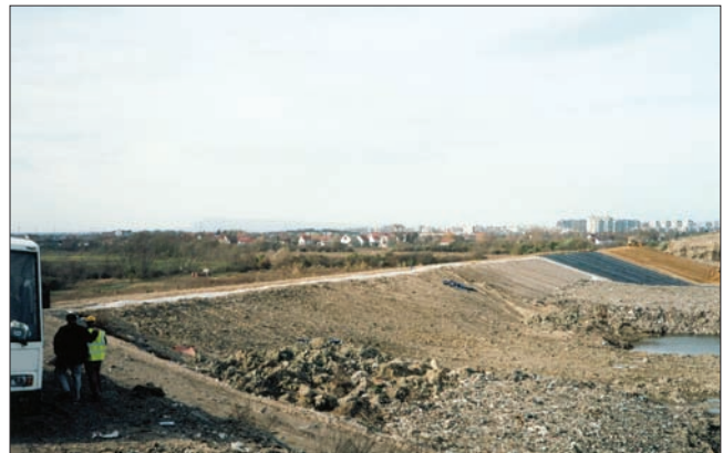
Fotografija 2. Radovi na sanaciji odlagališta Photo 2 Landfill remediation activities
