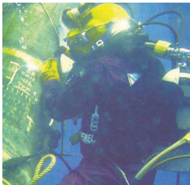
Figure 6 Underwater wet welding of platform jacket Slika 6 Podvodno mokro zavarivanje na «jacketu» platforme
