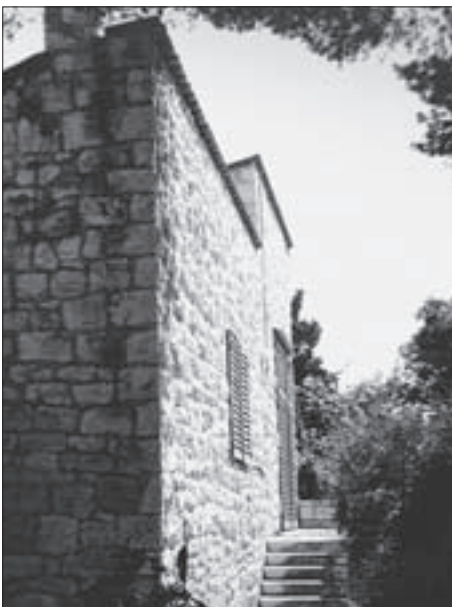
SL. 11. OBITELJSKA KUĆA DUKAT, HVAR, KRIZNI RAT 14, ZAPADNO PROČELJE FIG. 11 DUKAT FAMILY HOUSE, HVAR, 14 KRIZNI RAT, WEST FAÇADE
