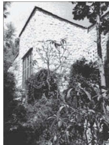
SL. 14. OBITELJSKA KUĆA DUKAT, HVAR, KRIZNI RAT 14, ZAPADNO I JUŽNO PROČELJE FIG. 14 DUKAT FAMILY HOUSE, HVAR, 14 KRIZNI RAT, WEST AND SOUTH FACADES
