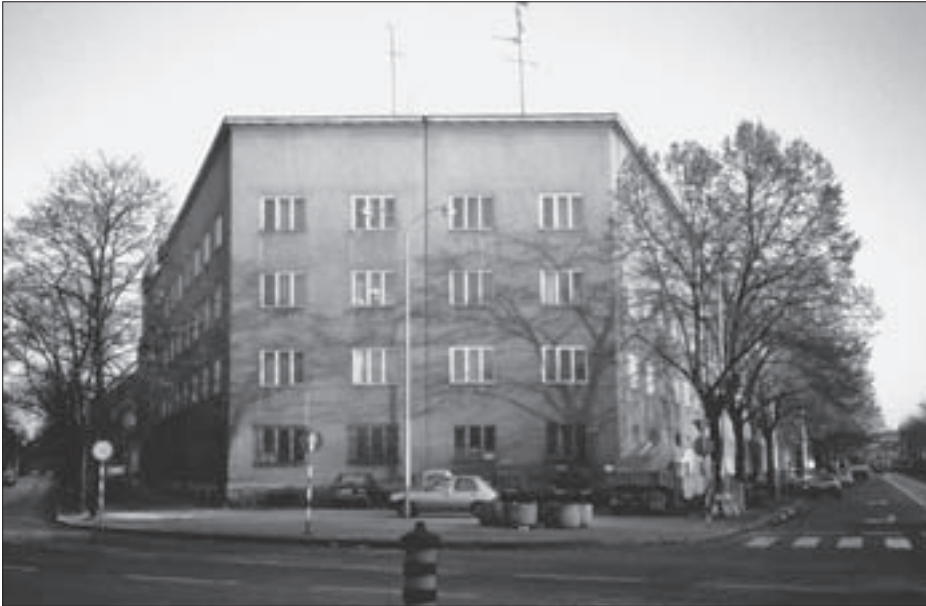
SL. 3. KUĆA ŽERJAVIĆ, ZAGREB, KRŠNJAVAČA 25/JUKIČEVA 36 FIG. 3 ŽERJAVIĆ HOUSE, ZAGREB, 25 KRŠNJAVAČA STREET/36 JUKIČEVA STREET
