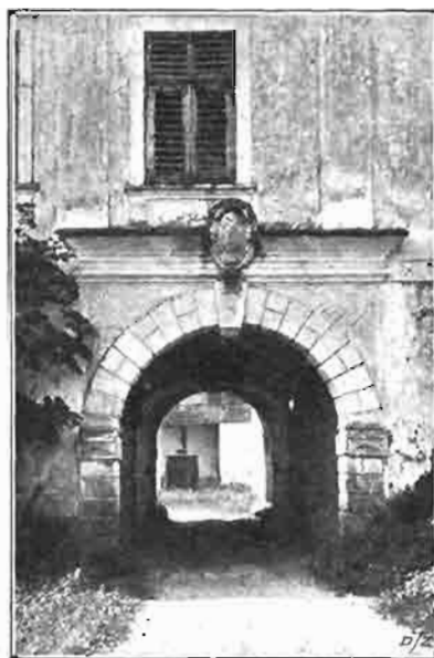
Sl. 77. Novi dvorl. Ulaz u grad.
