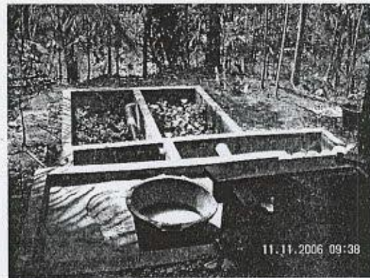
Gambar 1. Tata Letak ( lay-out ) IPAL Metode Fitoremediasi
