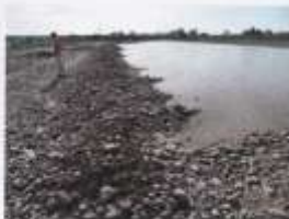
Foto 6. Vista hacia el Sudeste mostrando el terraplén que obstruye la boca del alcantarillado ubicado en el trazo medio del río y que dirige las aguas hacia el extremo Sur del punto, visible a la izquierda y fondo de la foto.
