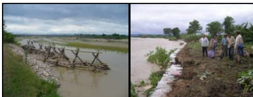
Imagen 13 y 14: patas de gallo y trabajo de defensa con bolsas de arena
