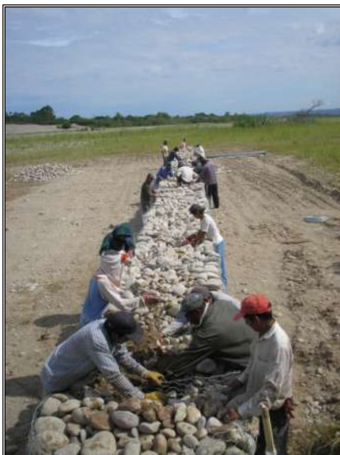
Imagen 16: Construcción comunitarias de gaviones
