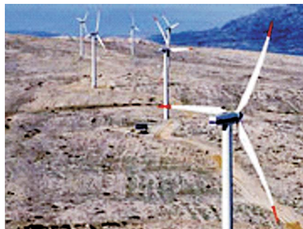
Figure 1 Wind power plant Ravne on the island of Pag Slika 1. Vjetroelektrana Ravne na Pagu
