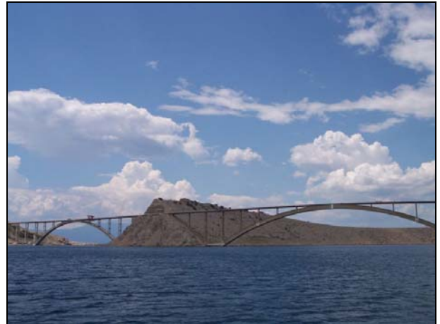
Slika 1. Fotografija Krčkoga mosta
