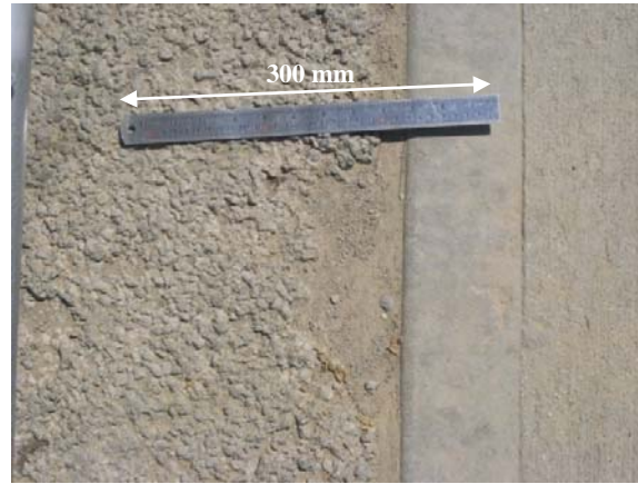
b) Spalling
